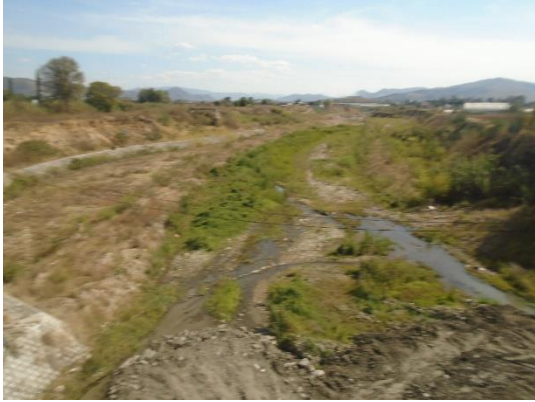
Foto 1. Sitio en el cual se desarrollará la obra que forma parte del proyecto identificado como San Lorenzo Cacaotepec
