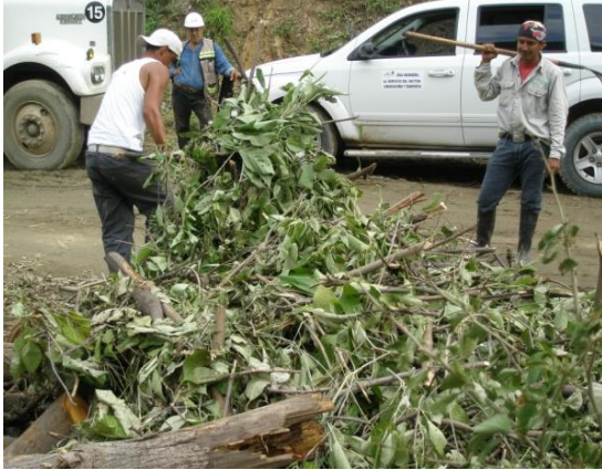
Foto VI. 7 Picado de ramas producto del desmonte
