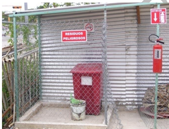
Foto VI. 9 Sitio de acopio y almacenamiento temporal de residuos peligrosos, en donde se indica el tipo de material resguardado en el área y extintor señalado adecuadamente.
