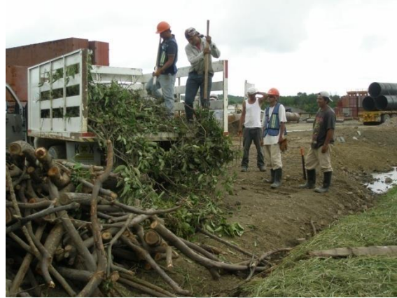
Foto VI. 8 Incorporación de material vegetal al suelo producto del despalle.
