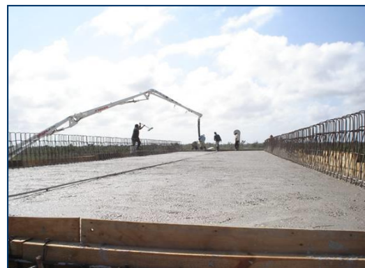
Imagen II.7 Proceso de habilitado y colado de la losa en obras similares.
