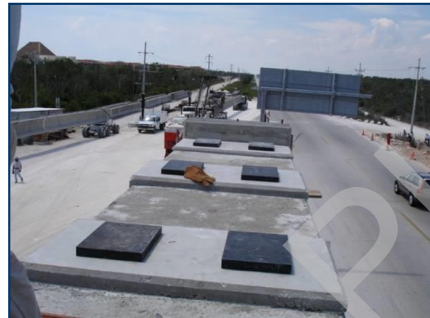
Imagen II.6 Proceso gráfico del montaje de traves.
