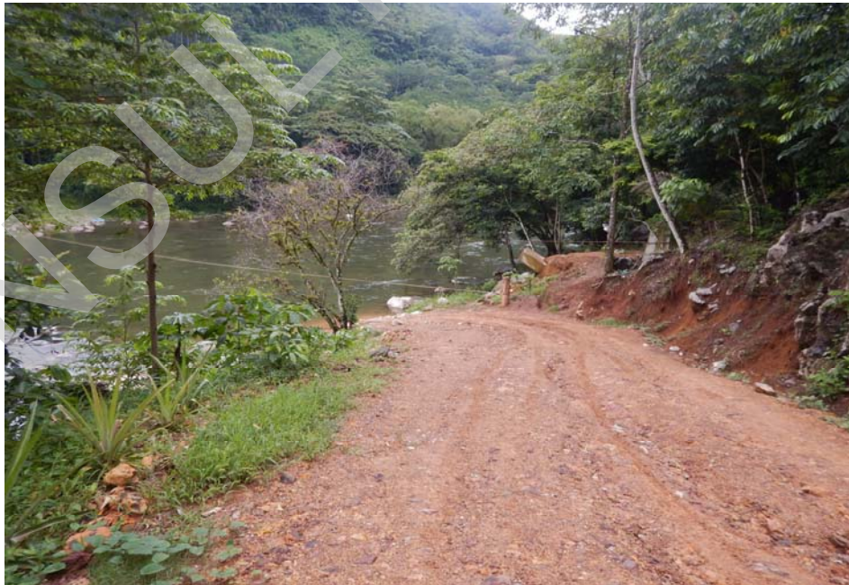
Foto 6.- Se observa las condiciones actuales del camino acceso 1.
