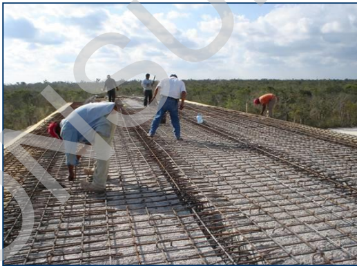
Imagen II.7 Proceso de habilitado y colado de la losa en obras similares.
