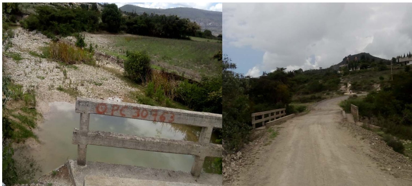
Figura IV.18. Puente existente en la corriente Rio Blanco km 5+970 el cual se respetara
