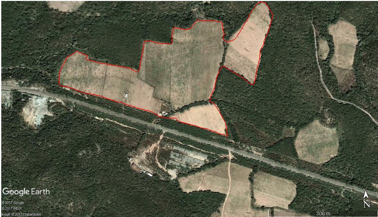
Figura II.3. Posible sitio de tiro temporal, bodegas, patios de maquinaria y almacenes ubicado en el km 154+800 de la carretera Mitla-Tehuantepec II.
