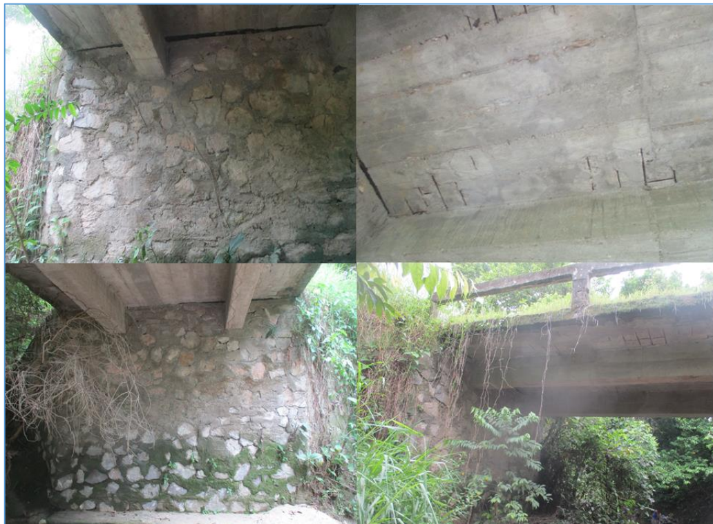
Figura IV.21. Panorámica de la estructura del puente que actualmente se encuentra operando.
