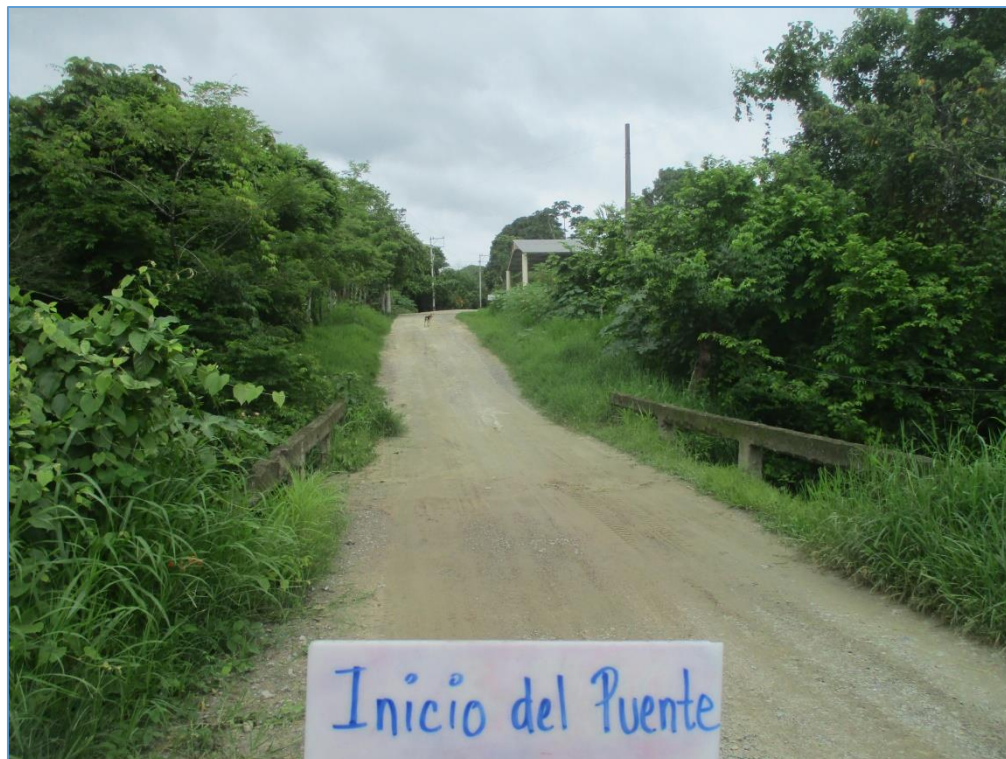
Figura IV.18. Panorámica del inicio del puente.
