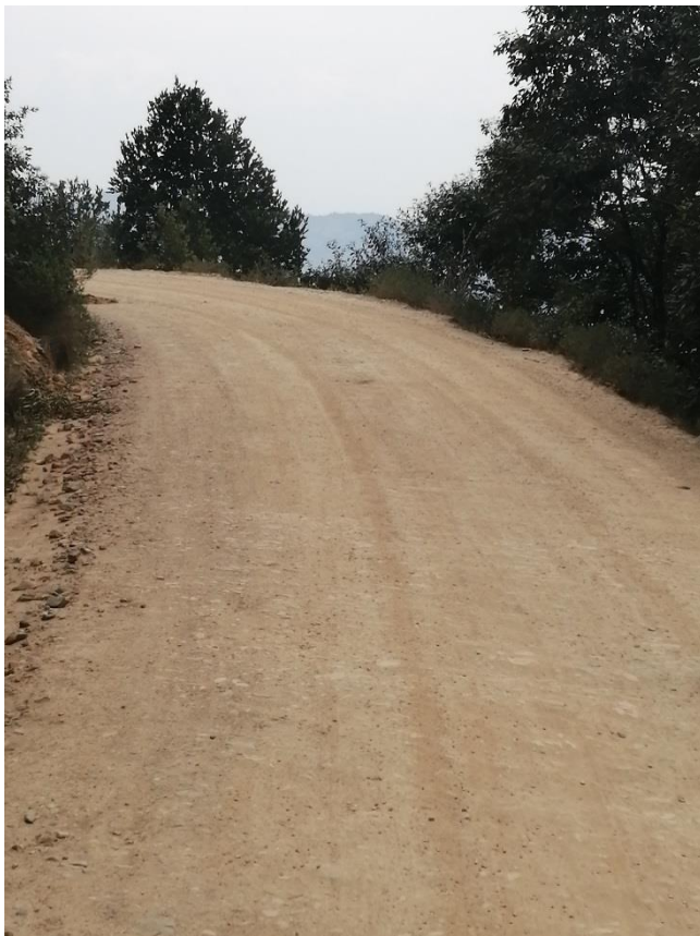
Foto 20. Vista de camino a partir de la marca de km 2+000 hacia km 0+000, se puede observar que en el trazo del camino hay curvas cerradas que cumplen con las características de un camino tipo E, en esta parte sí se cumple con el ancho de corona de 7.00 m.
