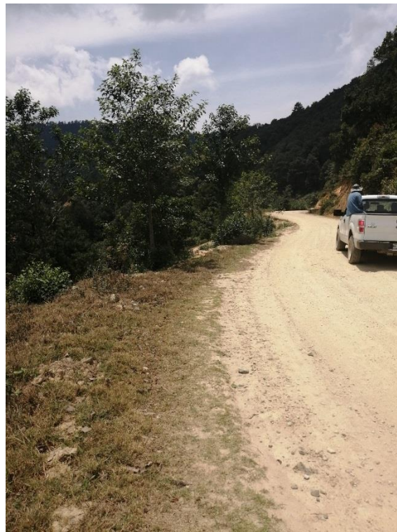
Foto 14. Vista del camino a partir de la marca de km 1+450 hacia km 10+000, a la margen derecha e izquierda se puede observar vegetación en buen estado de conservación, bosque de pino y encino el ancho del camino en este tramo es suficiente para la corona de 7.0 m.
