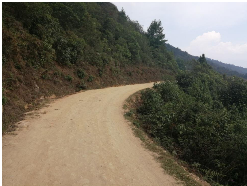
Foto 34. Vista del la marca de km 6+500 hacia el km 0+000, se puede observar la vegetación del bosque de pino y encino en buena conservación y la franja de protección del camino.
