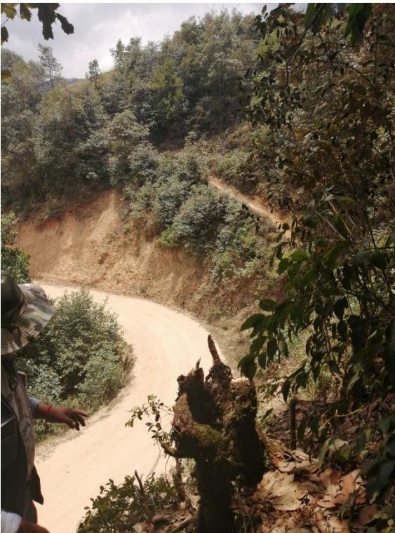
Foto 18. Vista del camino a partir de la marca de km 1+750 hacia km 10+000, se puede observar que en el trazo del camino hay curvas cerradas
