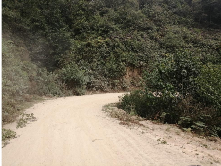
Foto 31. Vista del la marca de km 5+000 hacia el km 0+000, se puede observar en este tramo ya se tiene el ancho solicitado en proyecto, la zona protección del camino por parte de la población para mantener la visibilidad del camino.
