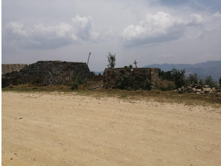
Foto 13. Vista del camino en la margen izquierda en el km 1+450 se encuentra el tanque de almacenamiento de agua potable que abastece a la agencia de Agua Duende.
