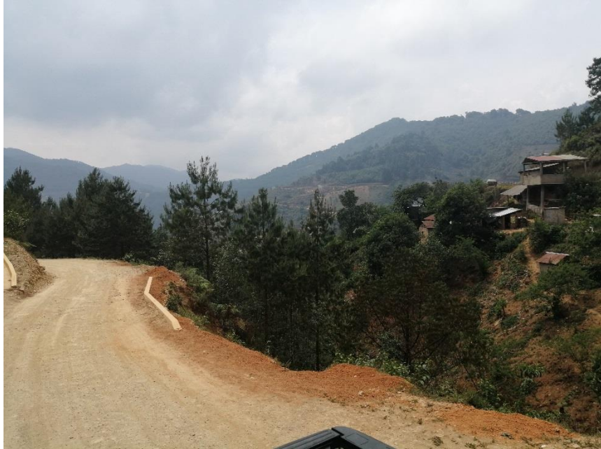
Foto 50. Vista del la marca de km 10+000 hacia el km 0+000 fin del tramo del proyecto presentado para autorización en materia de Impacto Ambiental. En este punto se ven ya las últimas viviendas de la agencia de San Isidro Zoquiapan.
