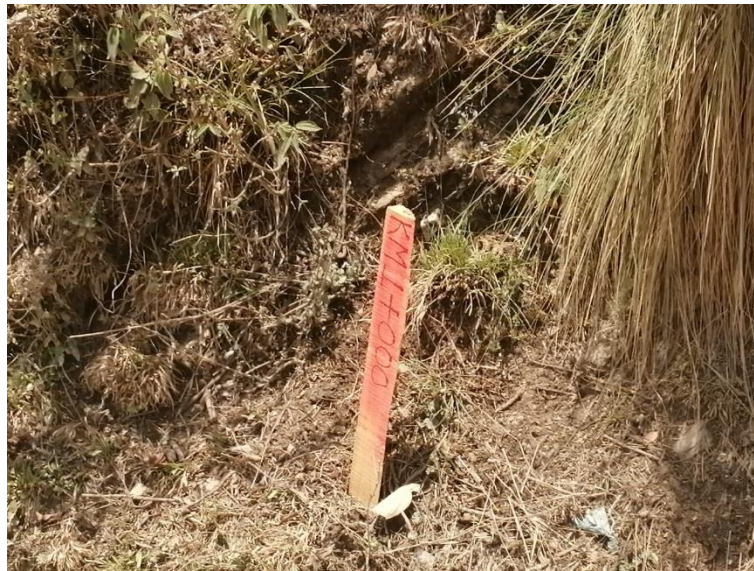
Foto 8. Vista del camino a la margen derecha, se puede observar la marca del kilometraje por parte de la brigada de topografía ubicando el km 1+000
