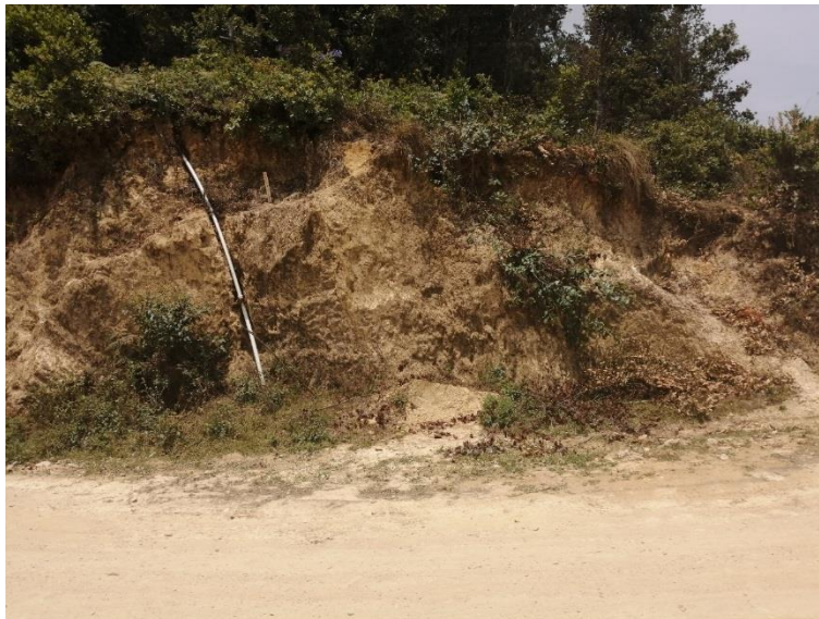
Foto 12. Vista del camino en la margen derecha en el km 1+450 se encuentra la tubería de agua potable que abastece a la agencia de Agua Duende.
