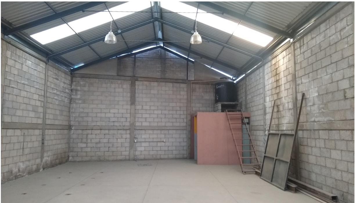
Figura 8.6. Foto tomada desde el acceso de la nave industrial. Aquí se aprecia la estructura de las instalaciones, el cuál ya fue aprobada por Protección Civil
