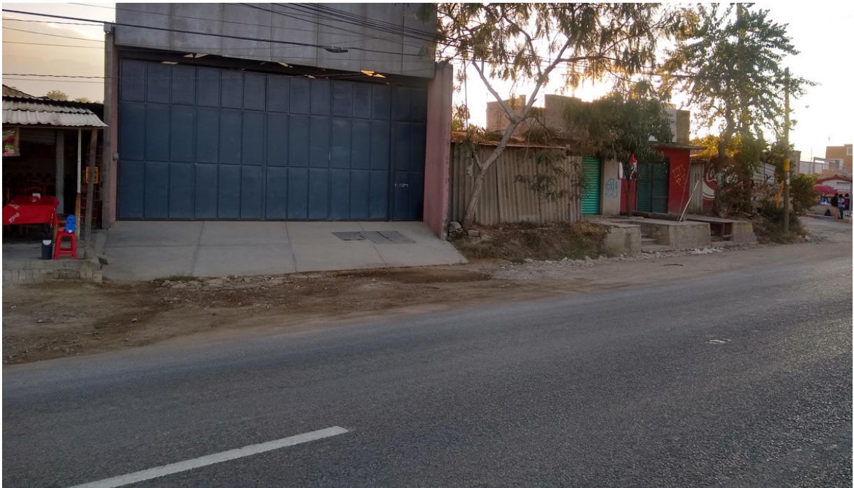
Figura 8.2. Foto de la vista frontal de la nave industrial donde se instalará el proyecto. Se observa que la nave esta frente a la Carretera Internacional 190. También se muestran algunas construcciones que son utilizados como locales comerciales
