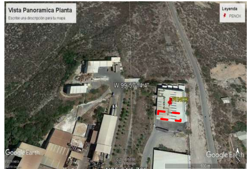
FIGURA I. VISTA ELEVADA DE PLANTA-PREDIO, MARCANDO EN CUADRO ROJO EL AREA A INSTALAR LA LINEA #6 DENTRO DE LA NAVE ACTUAL.
