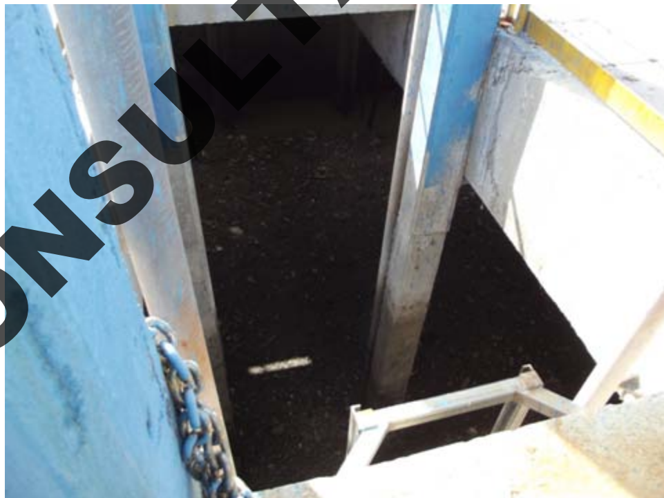
Llegada del colector al tanque homogenizados y sirve como derivación en caso de sobrepasar la capacidad de almacenamiento.
