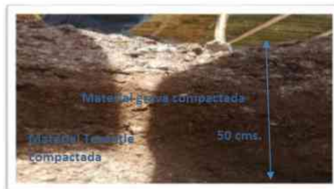
Figura 4. El área tiene un relleno y compactación, que no permite que las totugas pudieran desovar en el área.
