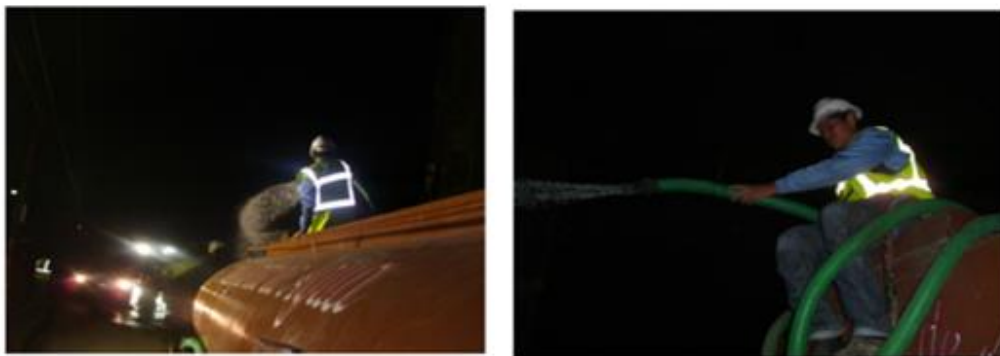
Figura 8. Ejemplo de riego para evitar emisiones de partículas suspendidas
