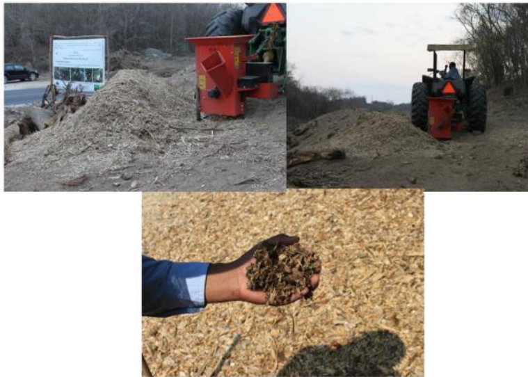
Figura 6. Ejemplo de la trituración y Composteo de material resultado del desmonte y despalme
