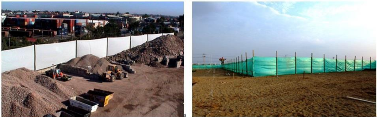
Foto 12.- Instalación de lonas de protección
