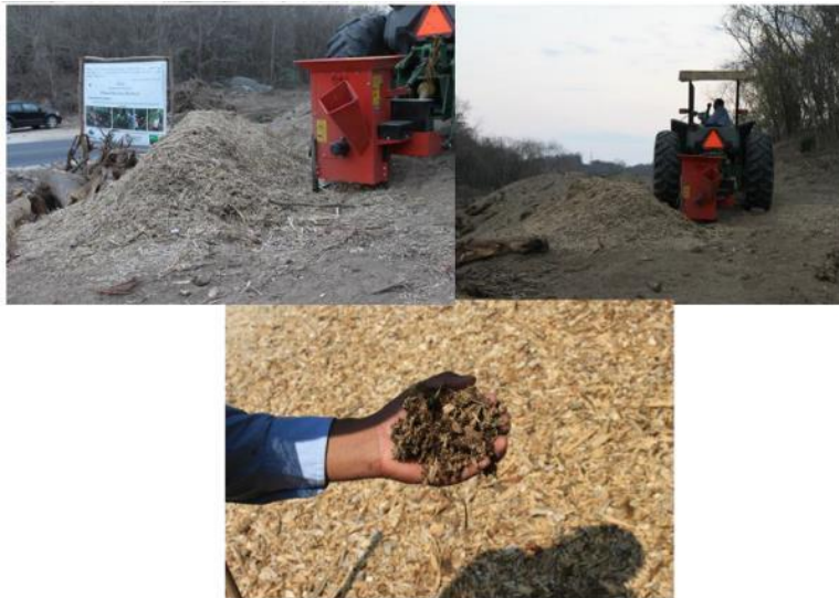
Figura 6. Ejemplo de la trituración y Composteo de material resultado del desmonte y despilme
