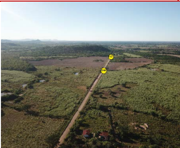
Vista superior desde dron de las obras de drenaje 09 a la 10.
