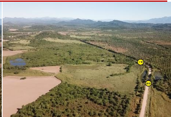
Vista superior desde dron de las obras de drenaje 19 y 20.
