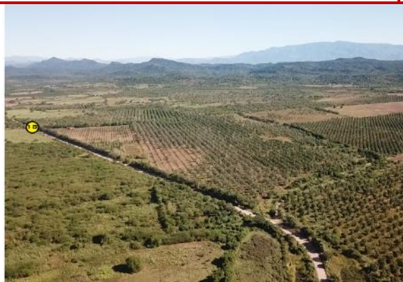
Obra de drenaje 18.
