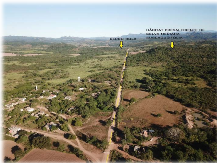
Fotografía VII. 1. Camino de terracería existente.
