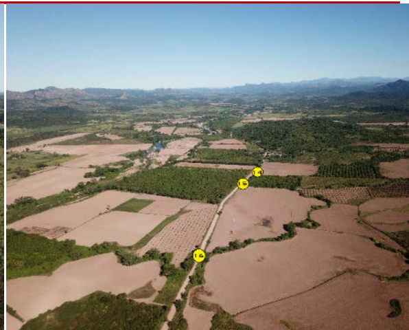
Vista superior desde dron de las obras de drenaje 14 a la 26.
