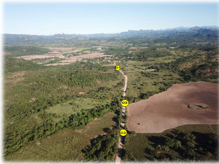
Imagen IV. 27. Cruce del trazo con microcuenca del cauce intermitente.
