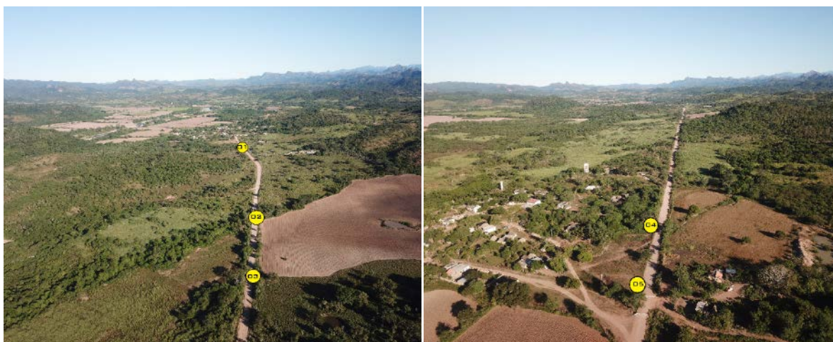
Vista superior desde dron de las obras de drenaje 01 a la 03.
