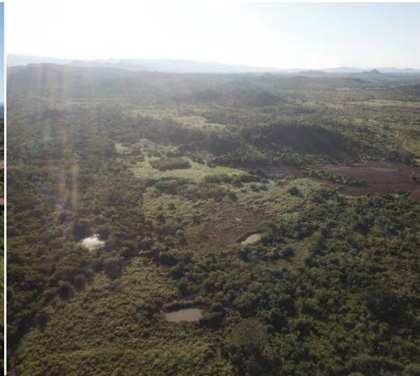
Vista superior desde dron de las obras de drenaje 07 a la 08.
