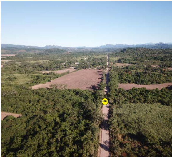
Vista superior desde dron de la obra de drenaje 06.
