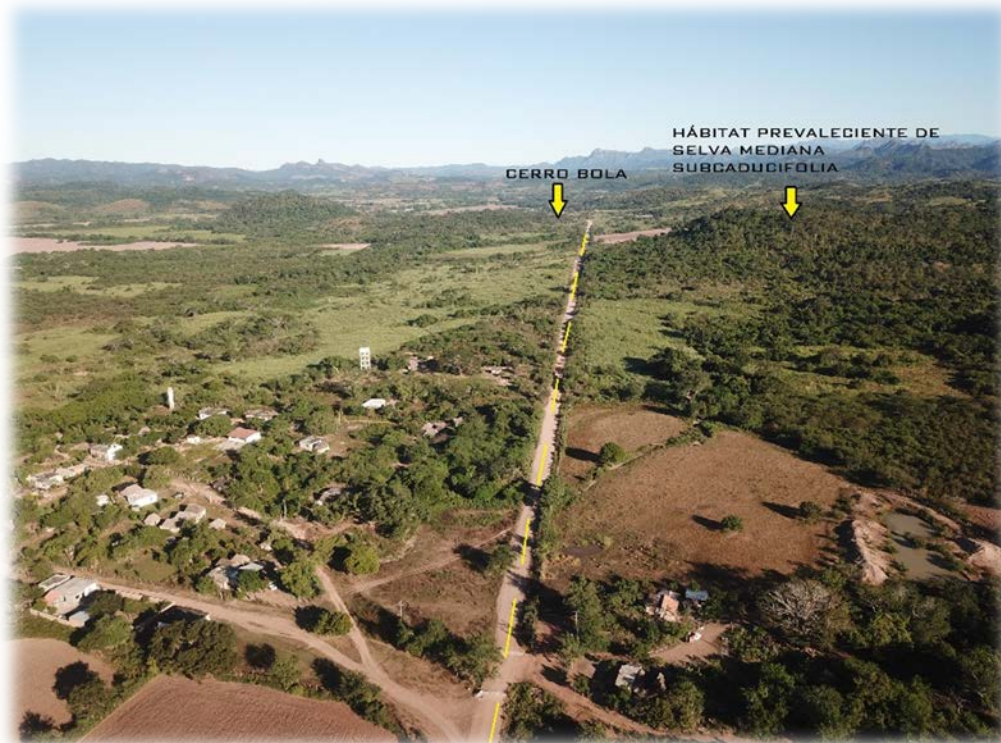
Fotografía V. 2. Modernización de camino vista norte montada sobre fotografía aérea.
