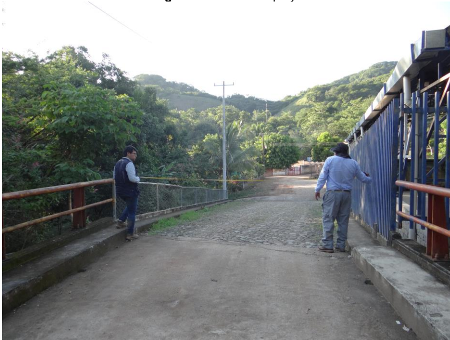
Fotografía I. 2. Final del proyecto
