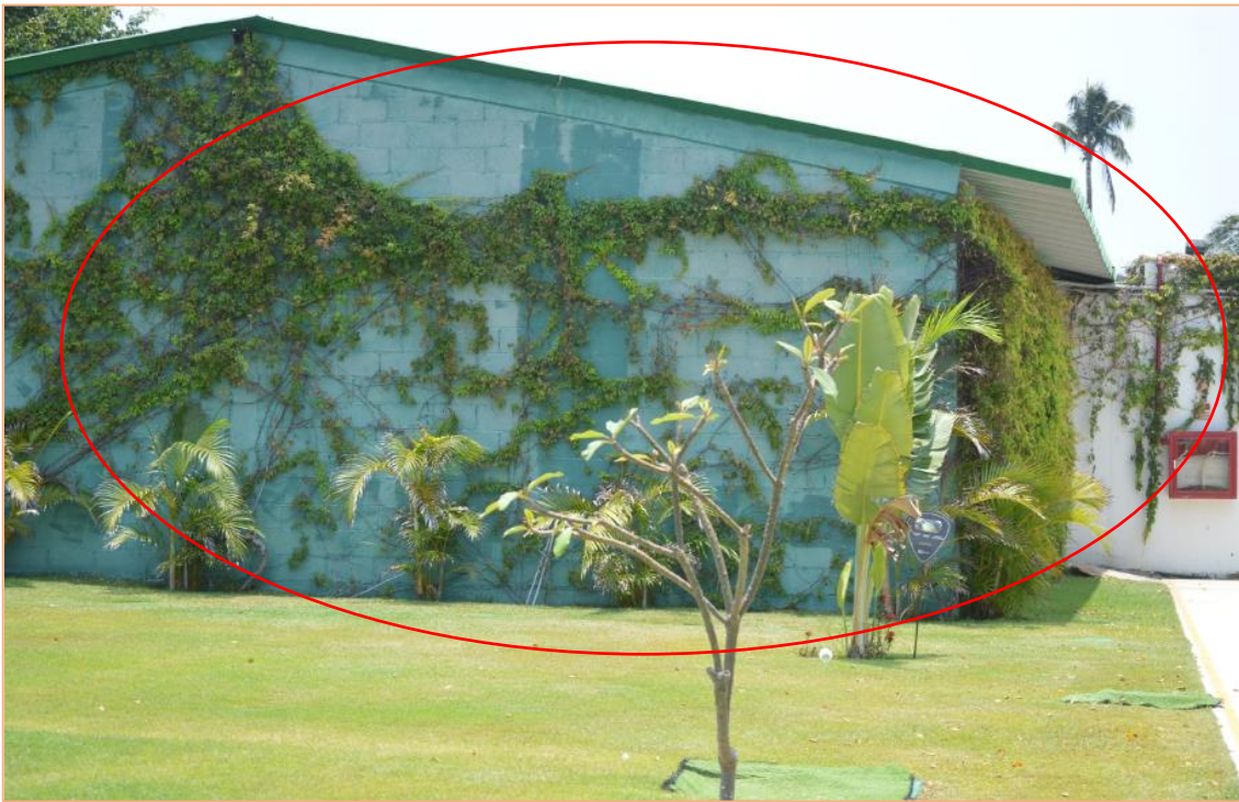
Fotografía No 7: Ubicación de la superficie de desplante de la Torre 5.
