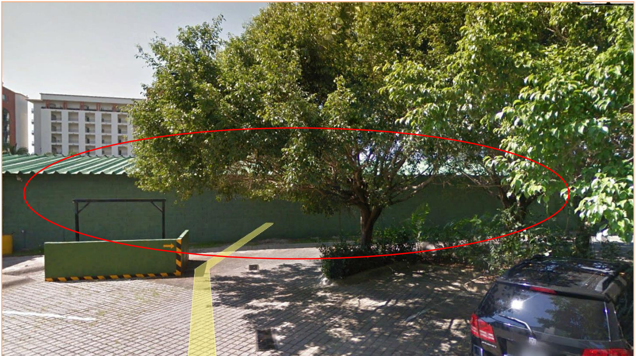
Fotografía No 5: Ubicación de la superficie de desplante de la Torre 5. Editado sobre fotografía satelital cortesía de GOOGLE EARTH.
