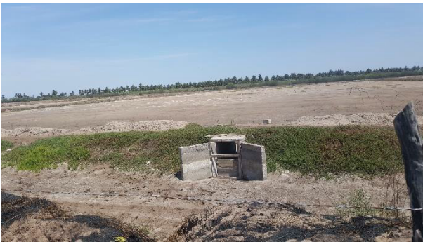
Figura 8 y 9. Estructura de las compuertas de entrada y salida de agua para cada una de las granjas, construidas a base de concreto.
