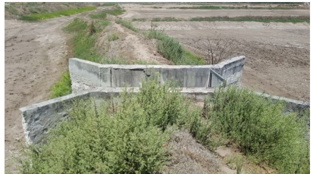
Figura 8 y 9. Estructura de las compuertas de entrada y salida de agua para cada una de las granjas, construidas a base de concreto.
