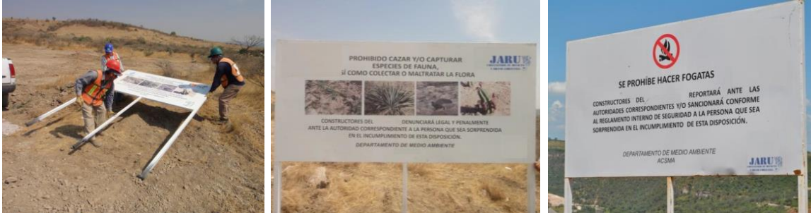
Figura VI.2. Letreros alusivos a las prohibiciones que se deben acatar durante la ejecución de la obra (imágenes de archivo, 2017).
