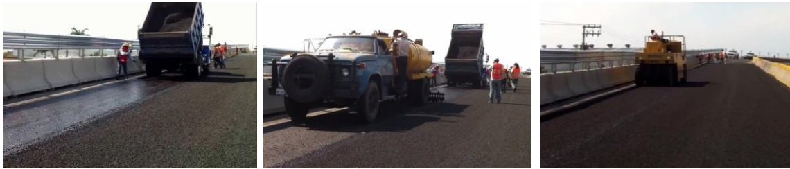
Figura II.6. Riego de Sello. Distribuidor vial en Cautla, Morelos (Imágenes de Archivo 2018).
