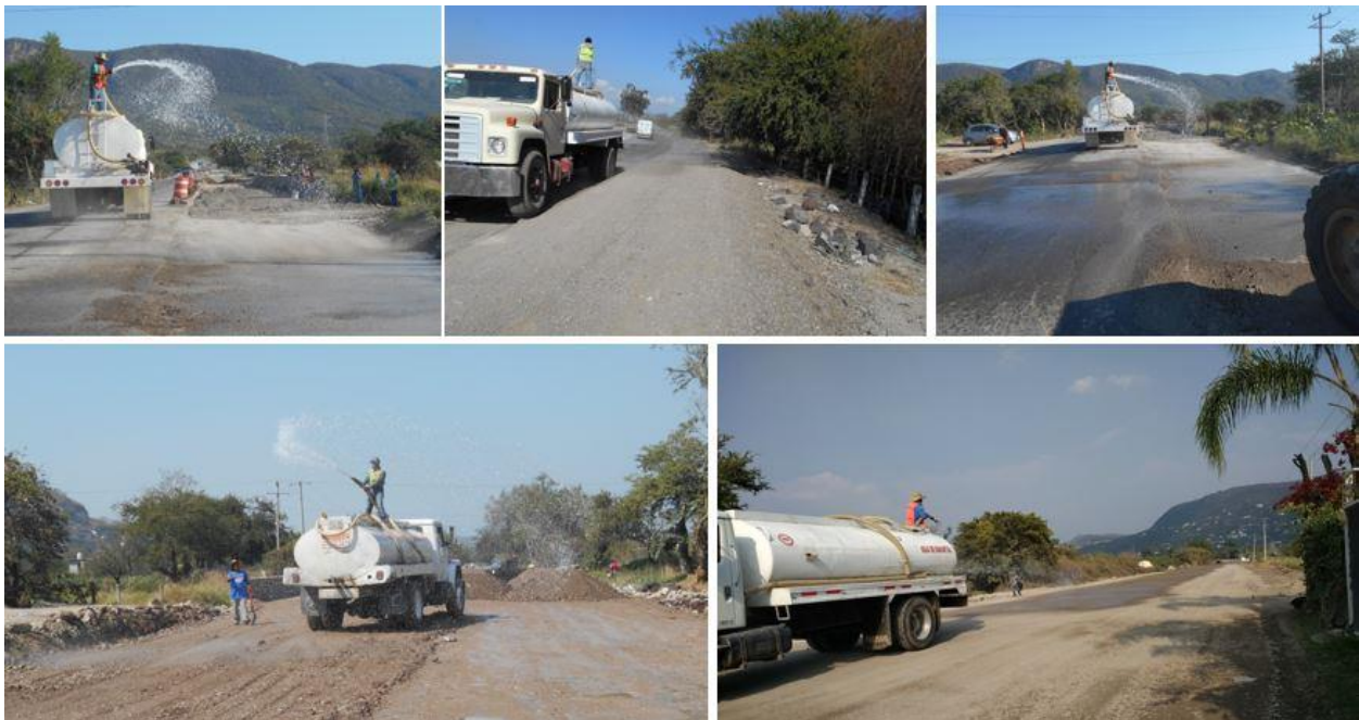
Figura II.9. Utilización de agua cruda para procesos de aspersión y riego, esta actividad reducirá el levantamiento de polvos productos del movimiento de tierras. (Imágenes de archivo 2018).
