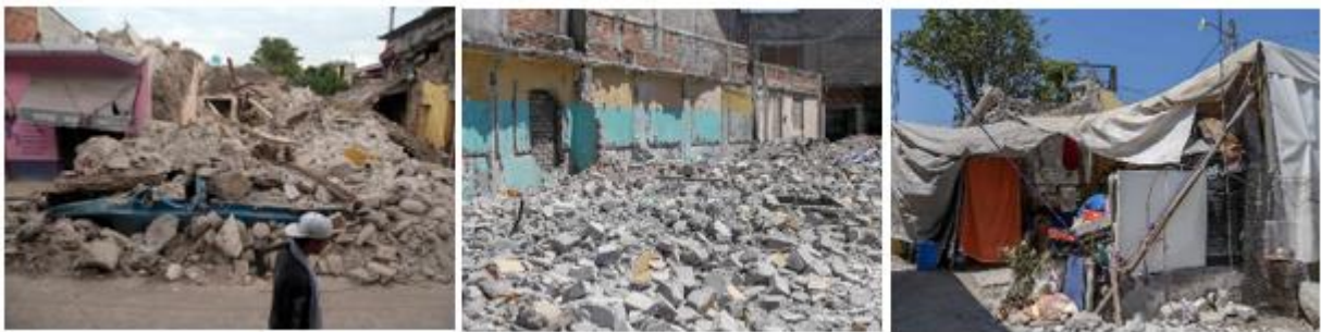
Figura IV.35. Estragos del evento sísmico del 19 de septiembre de 2017 en el Estado Morelos.
