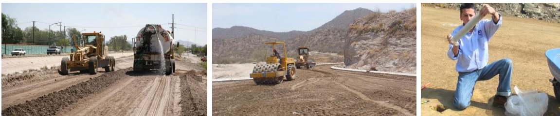
Figura II.5. Actividades de compactación y toma de muestras (imágenes de la red).
