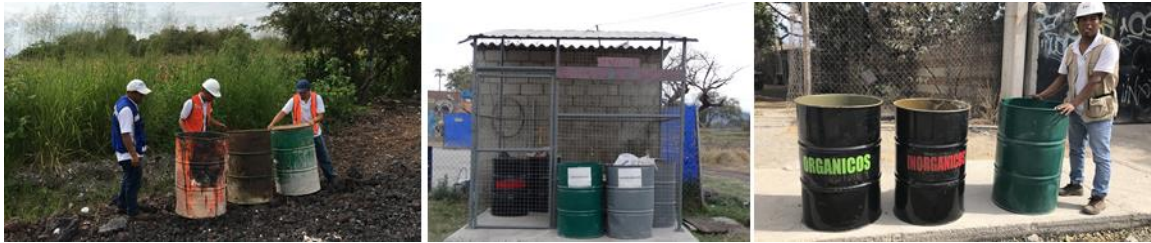
Figura VI.8. Contenedores al frente de obra (Imágenes de archivo; 2018).
