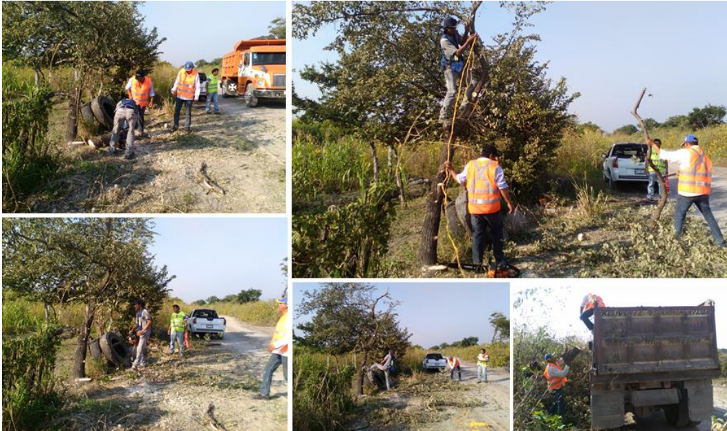
Figura IV.5. Trabajos de derribo de arbolado, retiro de arbustos y procesos de despalme en la modernización de un camino en el estado de Morelos (imágenes de archivo 2018).
