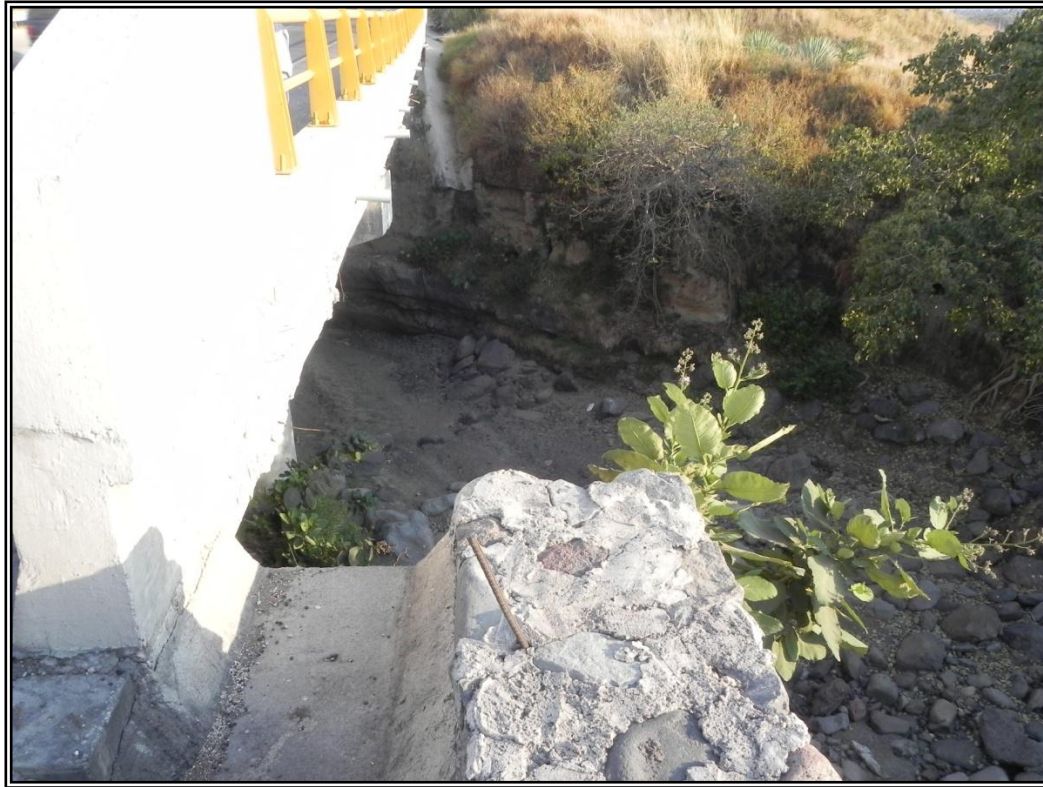
Foto 44. Cruce de arroyo. Puente los Guayabos (18° 46' 48.65" N – 98° 54' 02.92" O).
