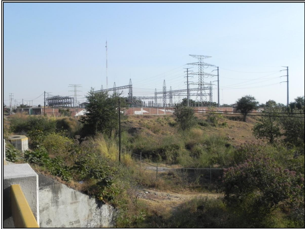
Foto 35. Subestación eléctrica. ( 18^{\circ} 50' 47.03'' N - 98^{\circ} 55' 53.26'' O).
