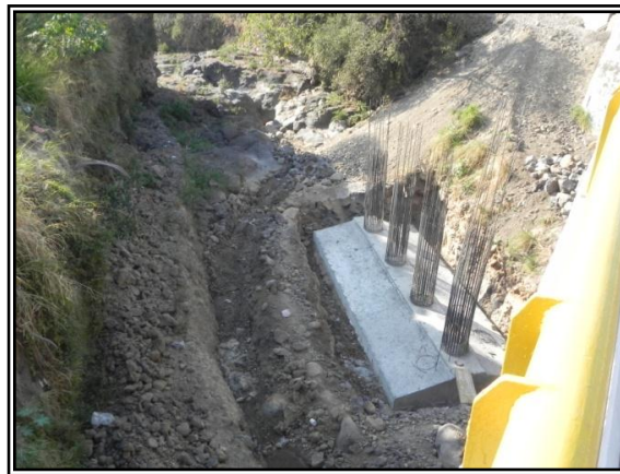
Foto II.1.6.10 Cruce del Río Yautepec, en el tramo localizado en la ciudad de Cocoyoc, el cual no presenta escurrimiento.
