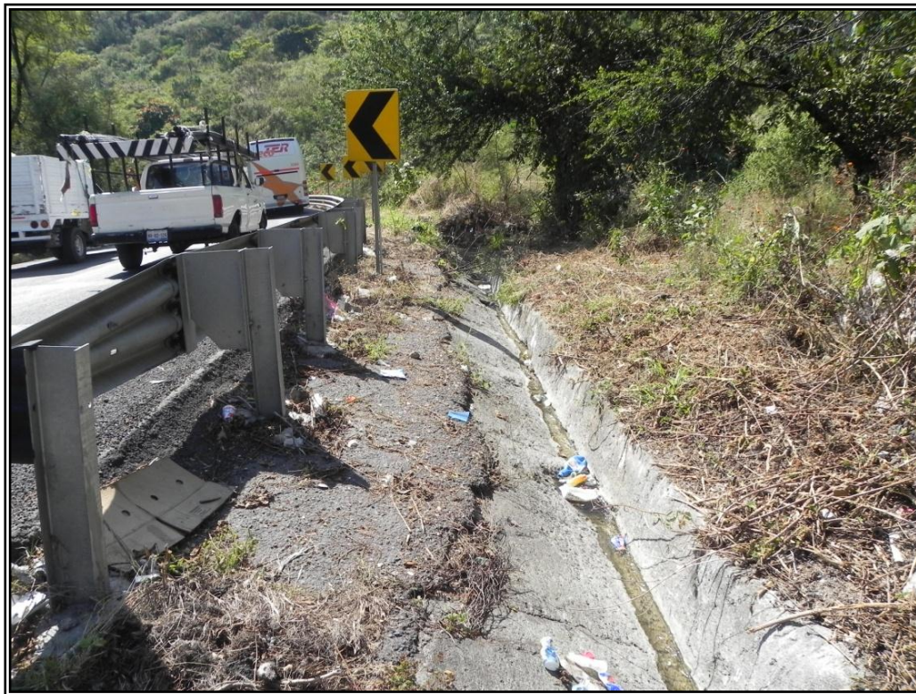
Foto 12. Derecho de vía de la carretera Federal No. 160, dentro del cual se instalará
