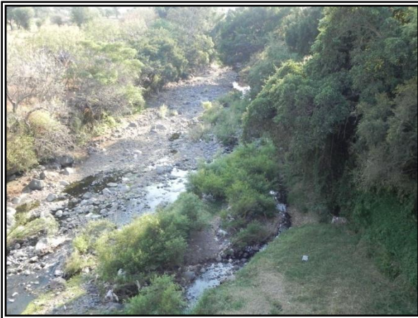
Foto IV.2.5.10 Cruce del Río Cuautla, carretera Federal No. 115.
