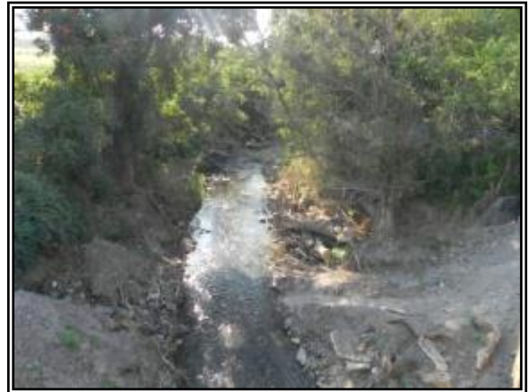
Fotos IV.2.5.6 Cruce del gasoducto con el Río Yautepec, carretera, Federal No. 115.
