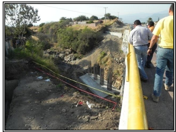
Fotos IV.2.5.8 y IV.2.5.9 Trabajos de obra civil por la ampliación de puentes vehiculares, en los cruces de Río Yautepec en la ciudad de Oaxtepec y Cocoyoc, intersección con la carretera Federal No. 115, correspondiente al área de influencia del trayecto del gasoducto proyectado.
