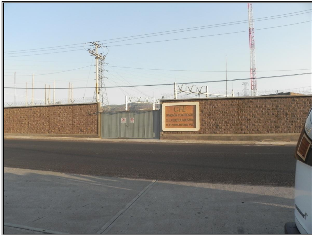
Foto 47. Subestación eléctrica (18° 46' 48.65" N – 98° 54' 02.92" O).
