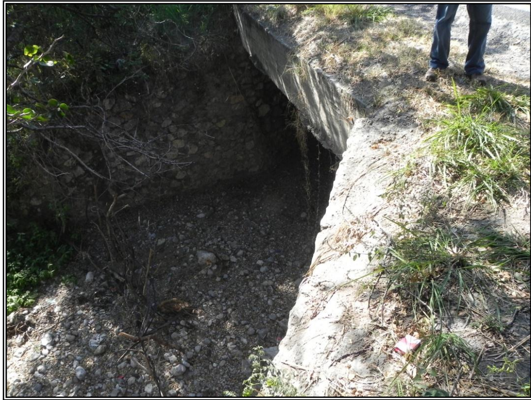
Foto 18. Cruce Pluvial ( 18^{\circ} 51' 29.39'' N - 99^{\circ} 06' 17.93'' O).
