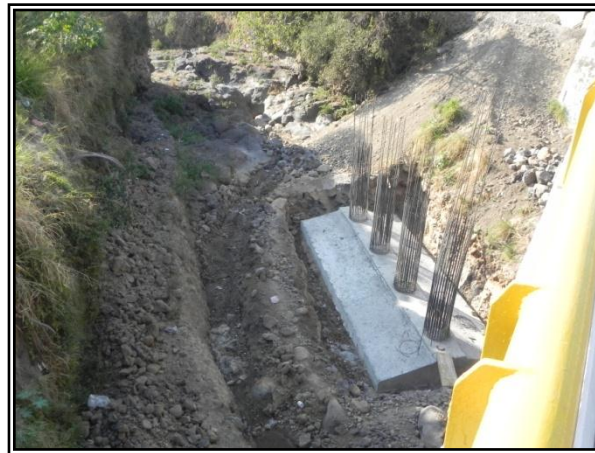
Foto IV.2.5.7 Cruce del gasoducto con el Río Yautepec, carretera Federal No. 115.
