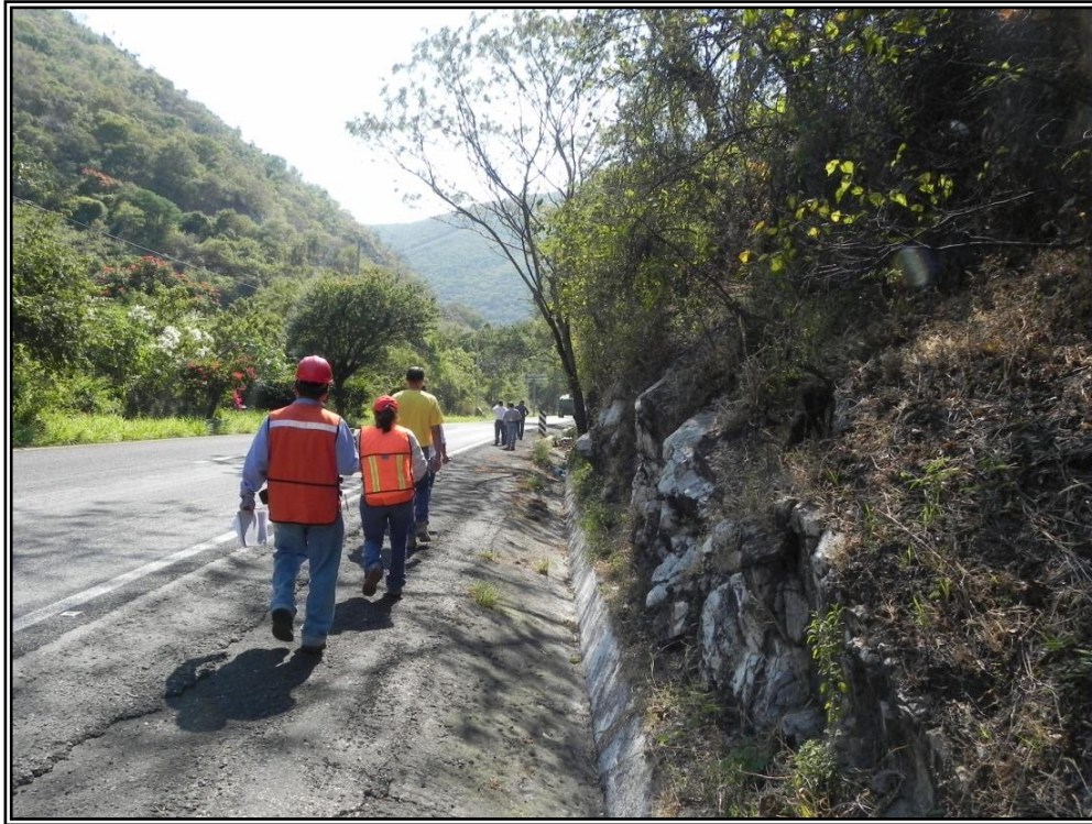
Foto 15. Derecho de vía de la carretera Federal No. 160, dentro del cual se instalará el gasoducto principal.
