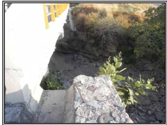
Fotos II.1.6.5 Cruce de arroyo, donde también se localiza el Puente los Guayabos.
