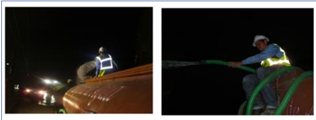
Figura 8. Ejemplo de riego para evitar emisiones de partículas suspendidas
