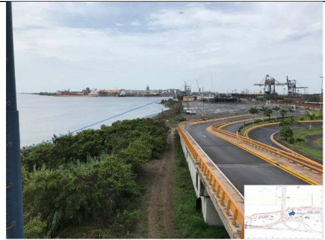
Figura II. 12. La línea azul muestra el alineamiento del canal para la construcción del muelle; al fondo se observa el actual patio de maniobras
