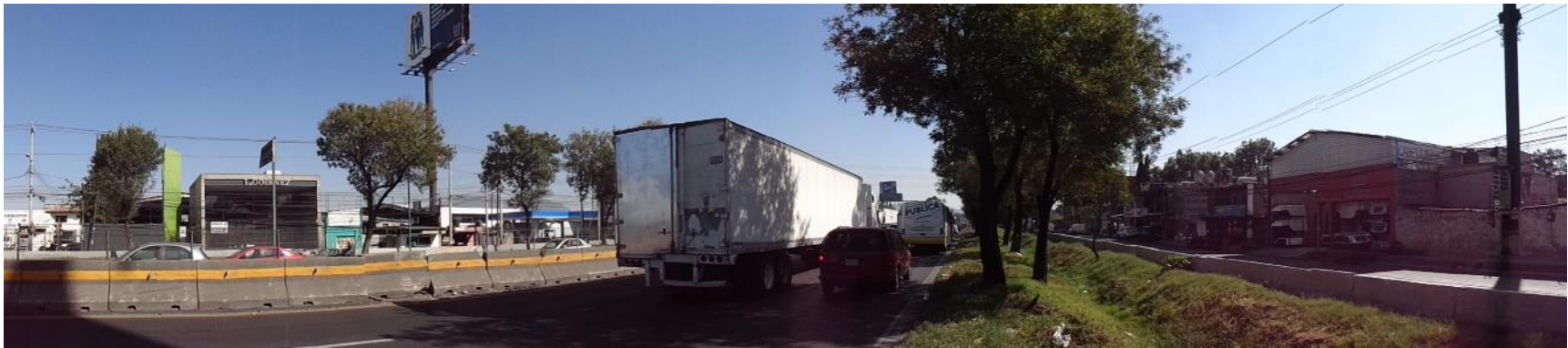
Figura I.4. Vista del Cuerpo Izquierdo del Viaducto Elevado Tepalcapa hacia el Circuito Exterior Mexiquense.
