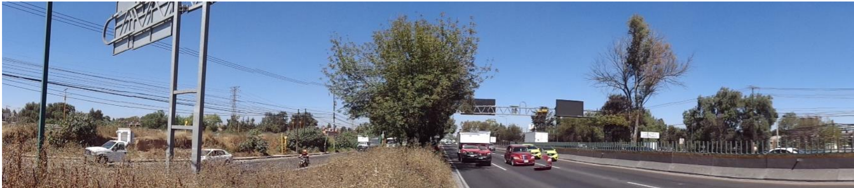
Figura II. 11 Vista del cuerpo izquierdo del Viaducto Elevado Tepalcapa hacia el Circuito Exterior Mexiquense.
