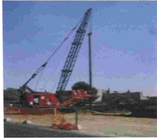
Grúa para pilotes
