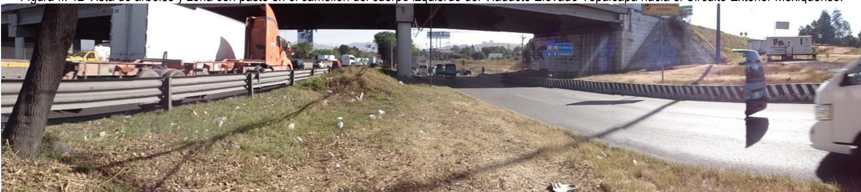
Figura II. 13 Vista de árboles y zona con pasto y el entronque con el Circuito Exterior Mexiquense.
