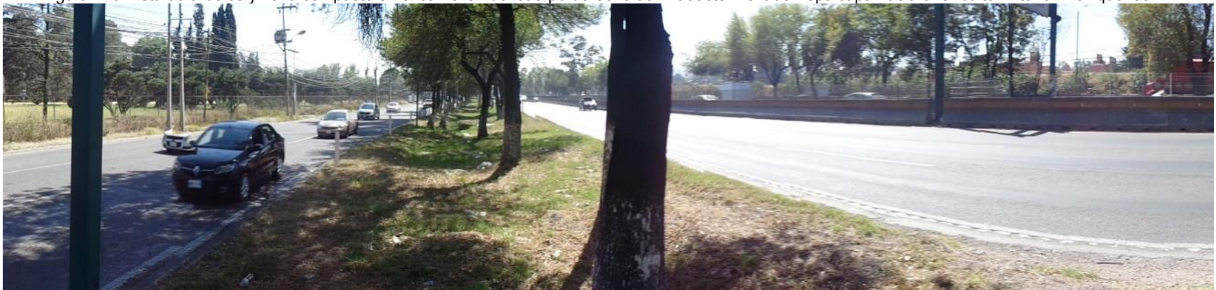
Figura II. 10 Vista de árboles y zona con pasto en el camellón del cuerpo derecho del Viaducto Elevado Tepalcapa hacia el Circuito Exterior Mexiquense.
