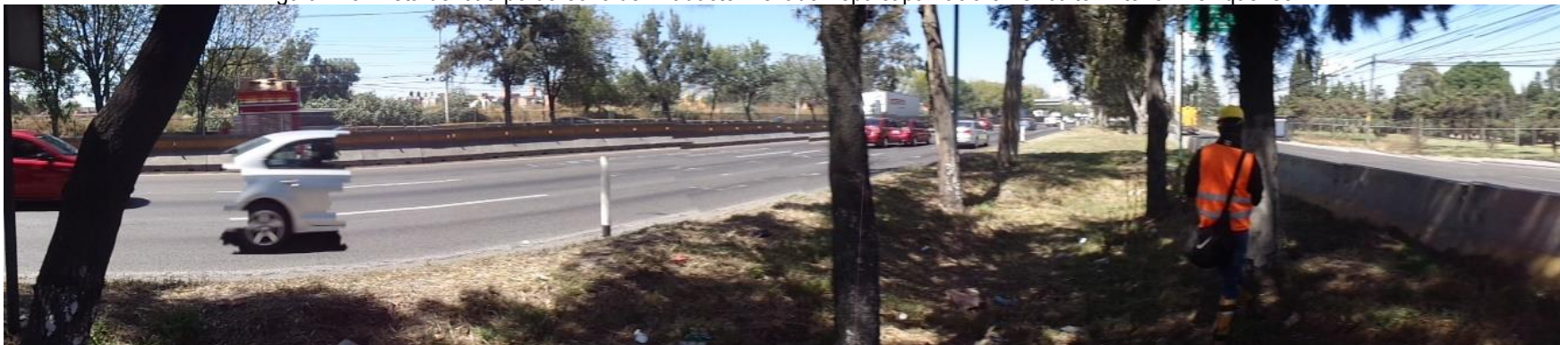
Figura II. 9 Vista de árboles y zona con pasto en el camellón del cuerpo derecho del Viaducto Elevado Tepalcapa hacia el Circuito Exterior Mexiquense.
