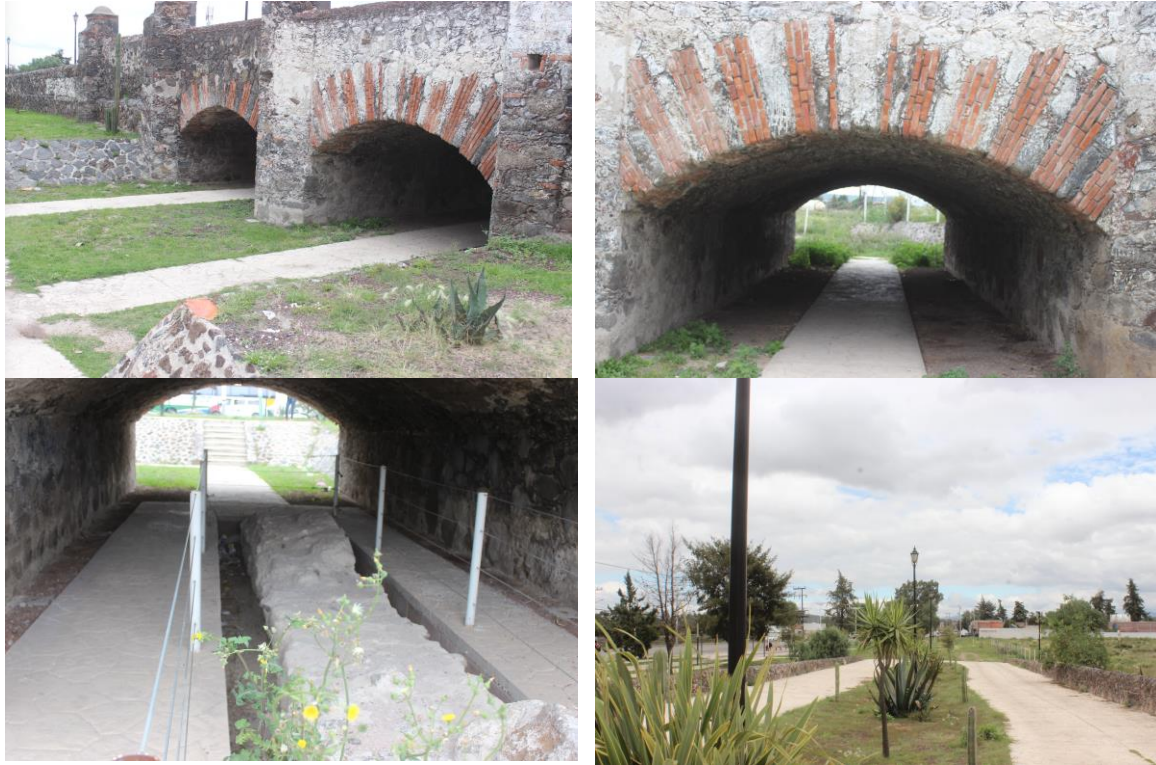
FIGURA III-5 FOTOGRAFÍAS QUE MUESTRAN UNA ZONA AJARDINADA QUE MUESTRA UN ACUEDUCTO QUE SE CONSIDERA DE IMPORTANCIA CULTURAL
