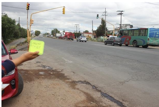
Se observa carencia de drenaje pluvial
