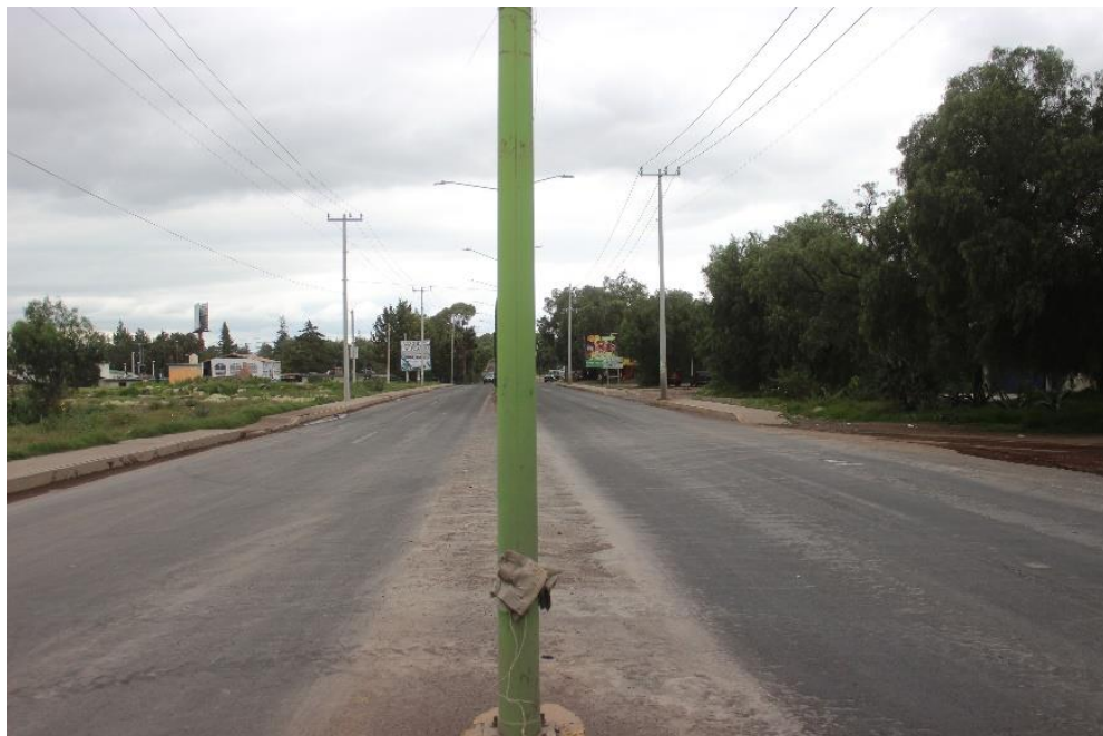
FIGURA II-59 VISTA DIRECCIÓN OESTE DESDE CAMINO A SAN JERÓNIMO, EN EL PUNTO CON LAS COORDENADAS X: 503227; Y: 2183417
