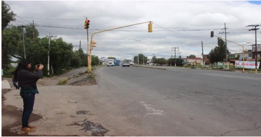
hacia Norte sobre Carretera Federal 85 México – Pachuca
