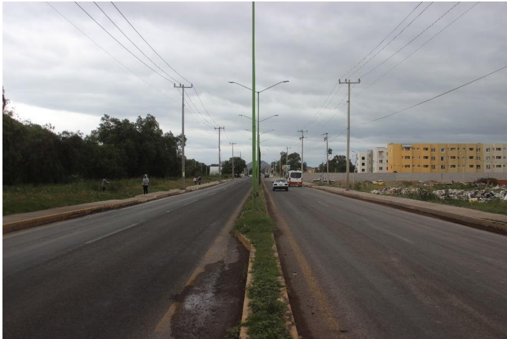
FIGURA II-60 VISTA DIRECCIÓN ESTE DESDE CAMINO A SAN JERÓNIMO, COORDENADAS X: 503227; Y: 2183417
