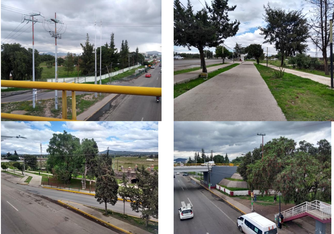
FIGURA V-2 CARACTERÍSTICAS DEL AIP CARRETERA LIBRE MÉXICO PACHUCA EN EL TRAMO TECÁMAC-ZUMPANGO -TIZAYUCA
