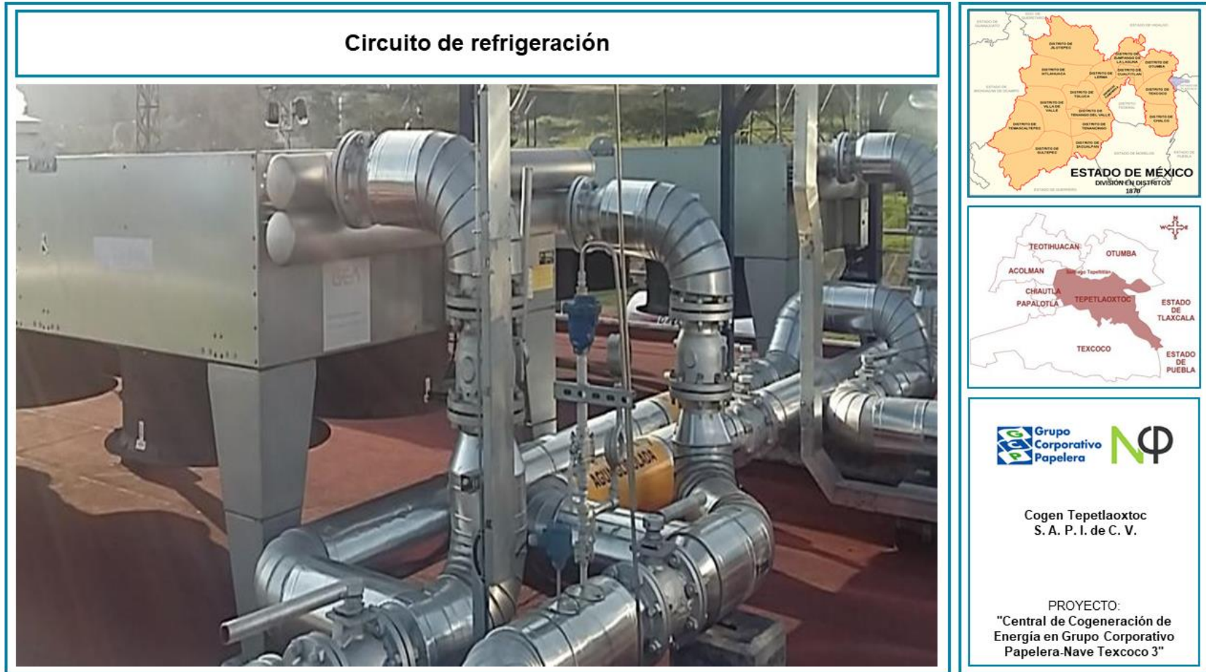
Figura II.13. Circuito de refrigeración.
