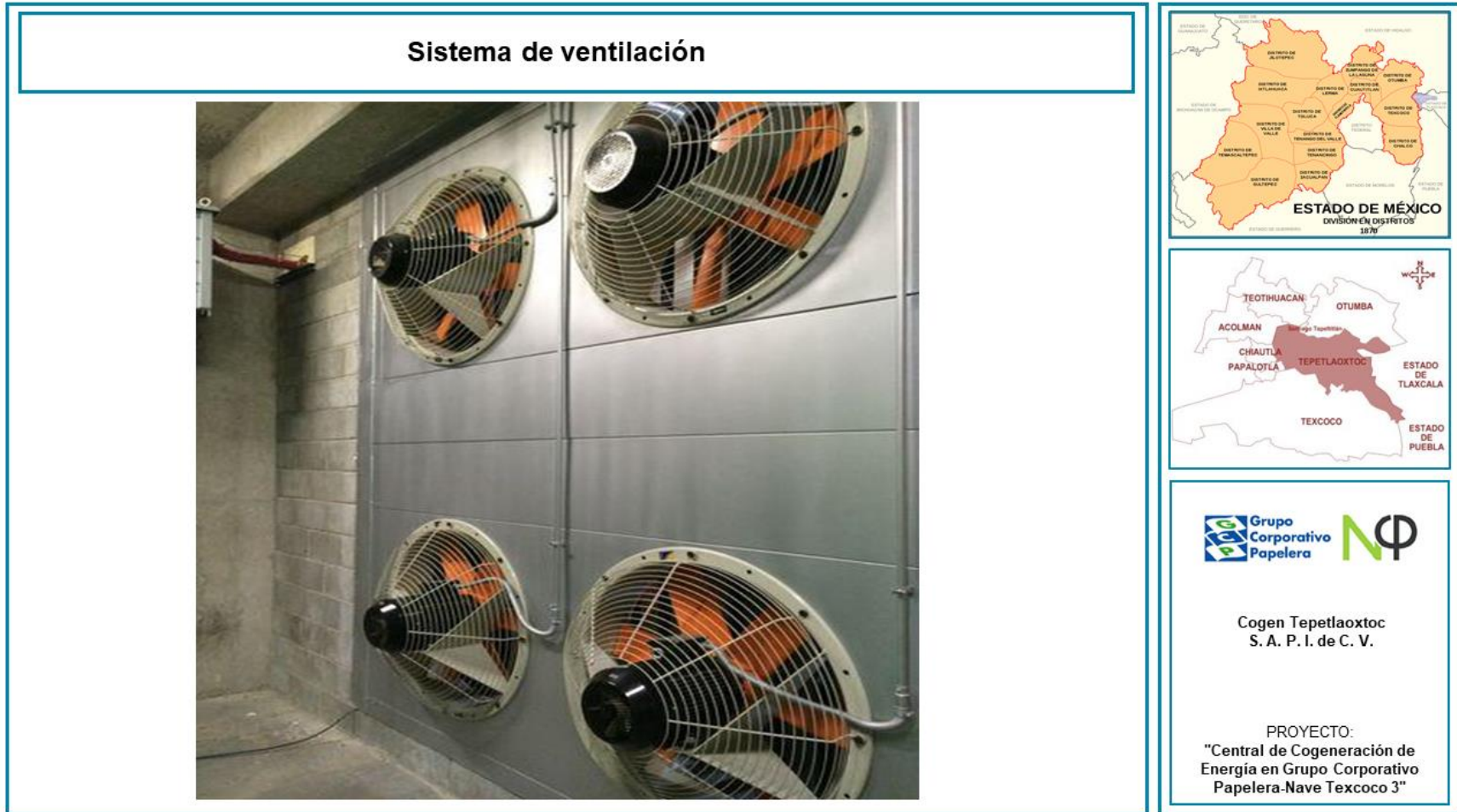
Figura II.15. Sistema de ventilación.
