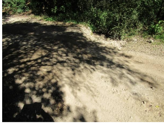
Lado derecho. Se prevé poca afectación, ya que el camino consta de más de 6.5 m de ancho y la afectación es sobre algunas herbáceas
