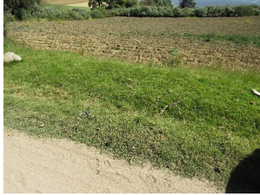
Lado derecho, afectación a cubierta de pasto
