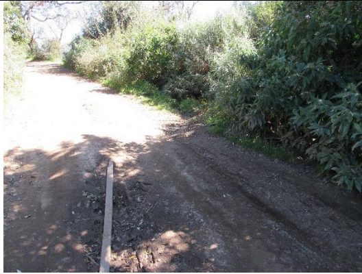
Aspecto del sitio donde se ha proyectado la obra, no existe obra de drenaje actual
