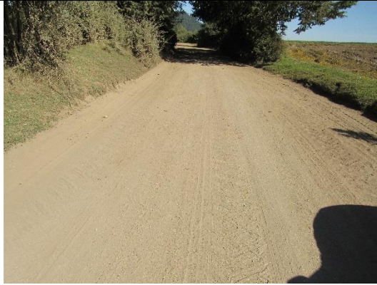
Aspecto del sitio donde se ha proyectado la obra, no existe obra actualmente
