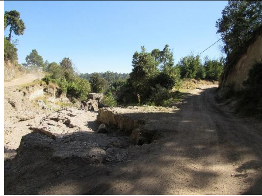
Lado derecho. Se prevé afectación a 2 elementos de Baccharis conferta , 1 de Buddleja cordata y de Photinia sp
