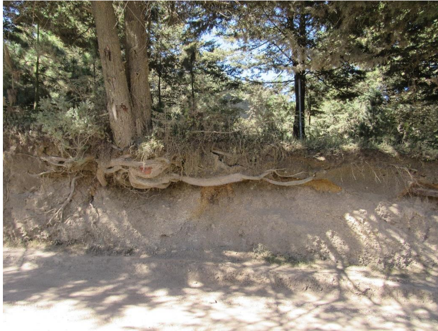
Figura 50. Km 7+000 hacia enfrente, en un subtramo de 160 m, se observan cipreses con las raíces descubiertas y por encima de la altura del camino, lo que es necesario remover algunos cipreses por seguridad (aproximadamente 8 individuos).
