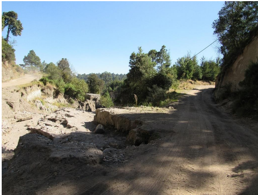
Figura 45. Panorámica del subtramo, la cubierta vegetal en la zona del Proyecto es casi nula
