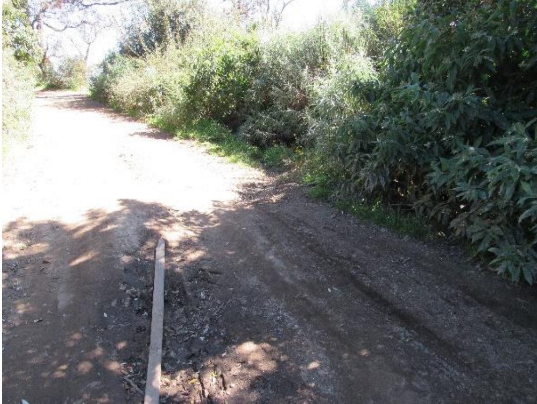
Aspecto del sitio donde se ha proyectado la obra, no existe obra de drenaje actual
