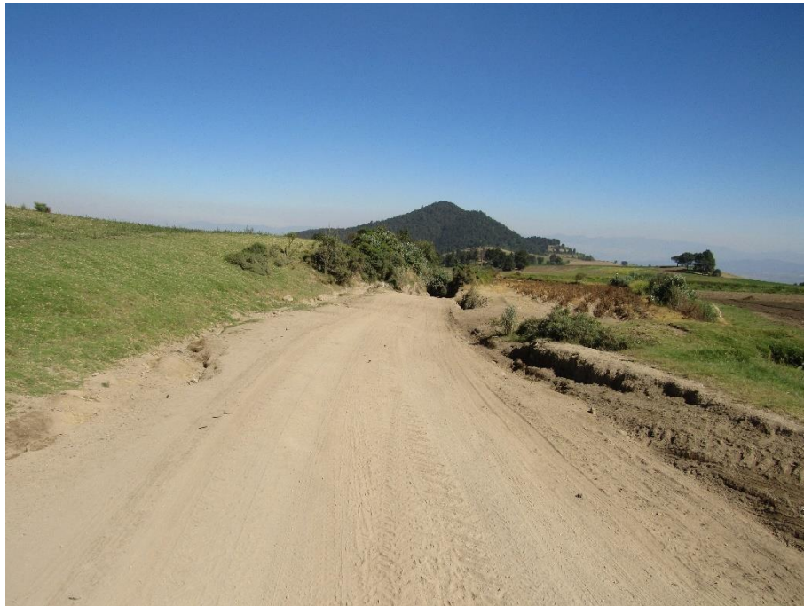
Figura 51. En este punto, que es el Km 7+200 hacia enfrente, se puede observar que el proyecto se encuentra embebido entre campos de cultivo, así como observar que los elementos arbóreos en las colindancias del camino son escasos
