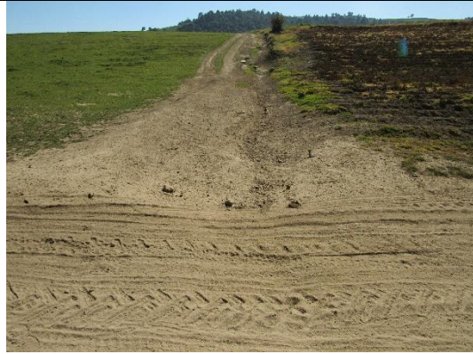
Lado derecho. Sin afectación a cubierta vegetal
