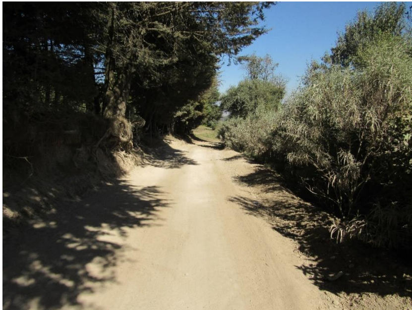
Figura 49. Km 7+000 hacia enfrente, en un subtramo de 160 m, se observan cipreses con las raíces descubiertas y por encima de la altura del camino, lo que es necesario remover algunos cipreses por seguridad (aproximadamente 8 individuos).
