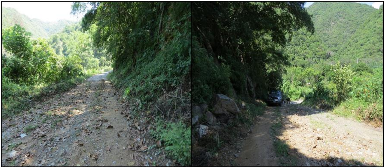
Figura 30. Vista de las condiciones actuales del km 1+469 donde terminarán las obras de mejoramiento y alineaciones al camino de acceso.
