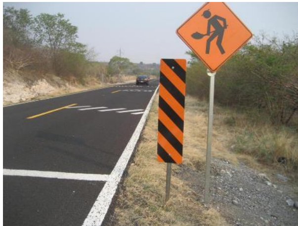
Figura 31. Señalamientos de protección de obra
