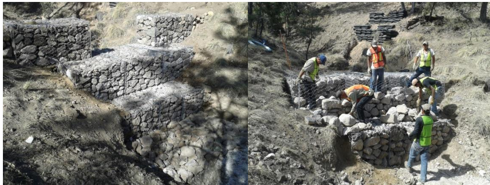
Figura 19. Construcción de una presa de gaviones.
