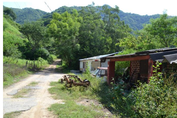
Figura 7. Localidad abandonada con camino deteriorado.
