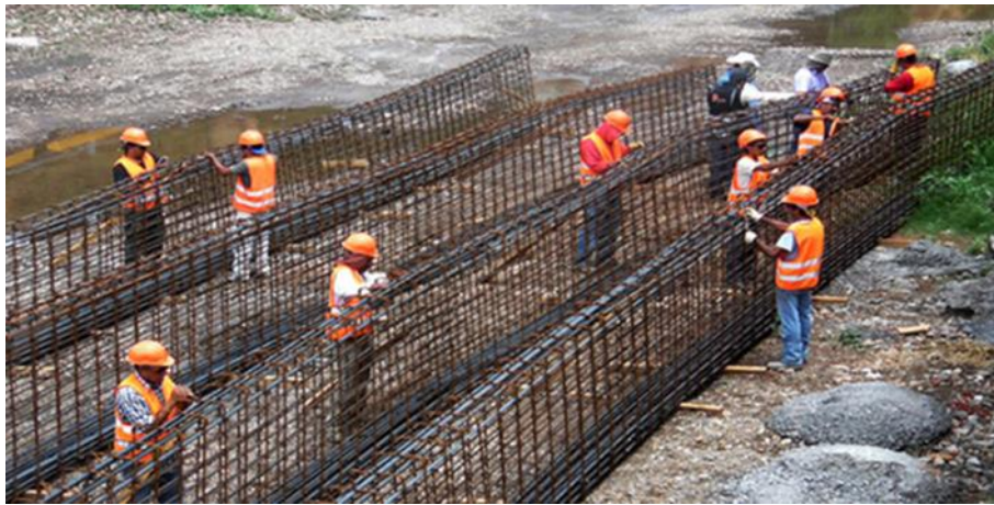
Figura 43. Armado de trabe prefabricada
