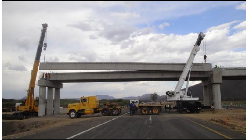
Figura 44. Montaje de traveses
