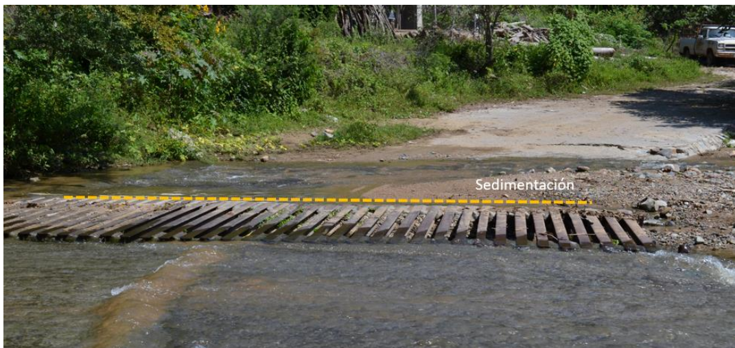
Figura 30. Sedimentación sobre la estructura actual.
