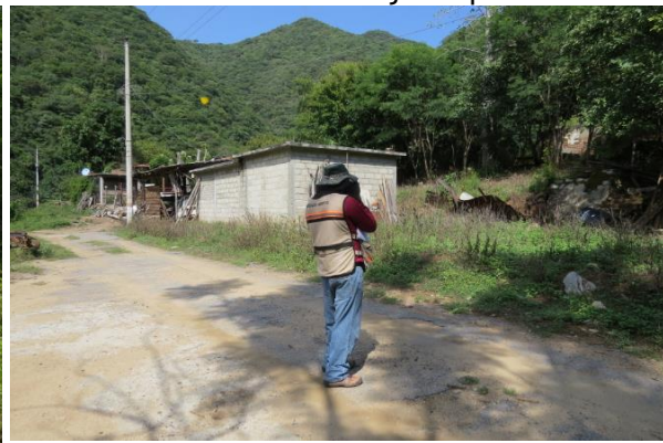
Figura 117. Viviendas en abandono en el sitio.
