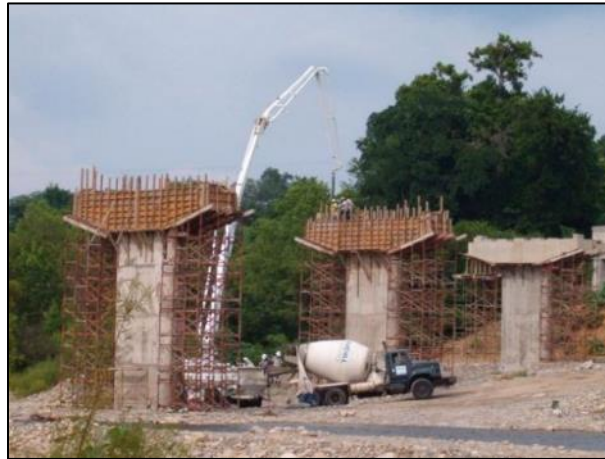
Figura 40. Ejemplificación del cimbrado de cabezales
