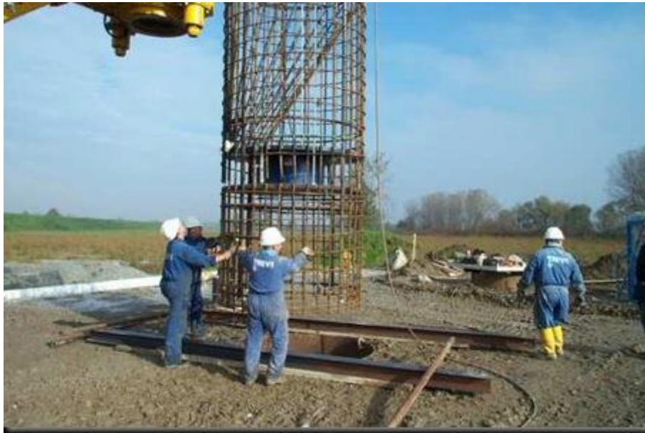
Figura 38. Ejemplificación de izaje y colocación de armado para pilas
