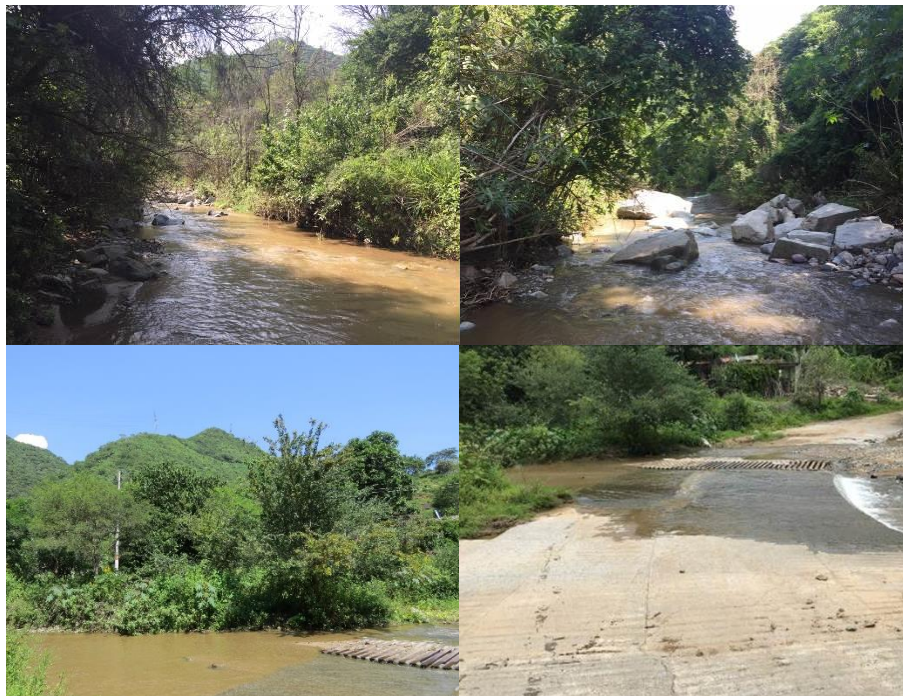
Figura 2. Río Tilostoc y estructura de paso actual.
