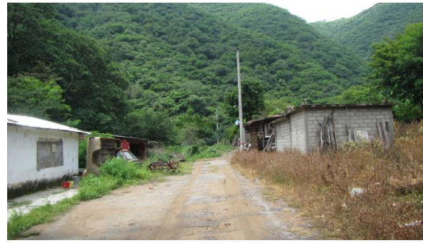
Figura 115. Viviendas en abandono y residuos de manejo especial.
