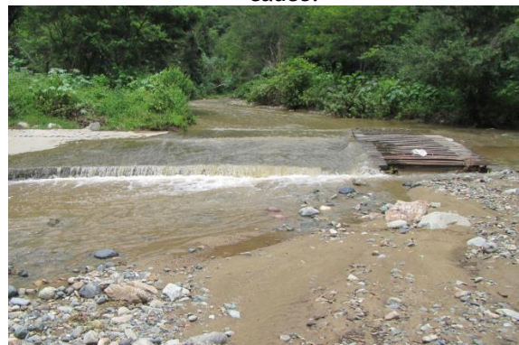
Figura 109. Losa provisional para el cruce de vehículos.
