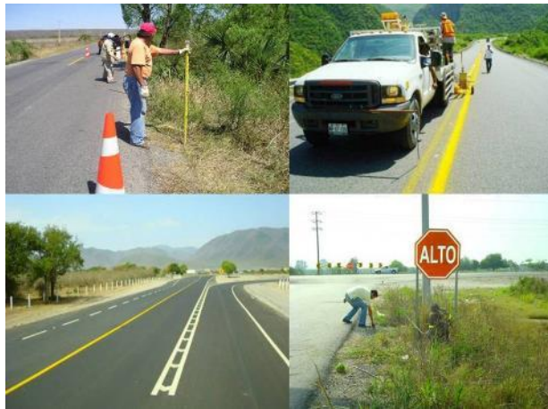
Figura 50. Ejemplificación de la colocación del señalamiento
