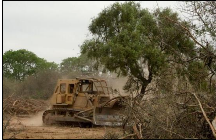
Figura 32. Ejemplificación del proceso de desmonte
