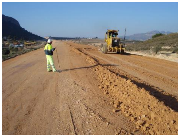
Ejemplificación de la conformación del terraplén
