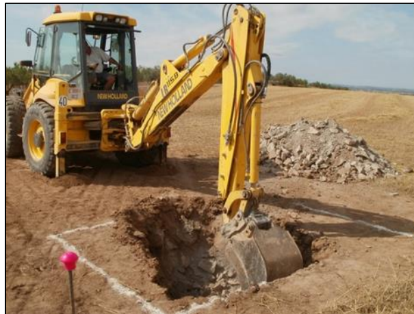
Figura 35. Ejemplo de la excavación para cajón de cimentación
