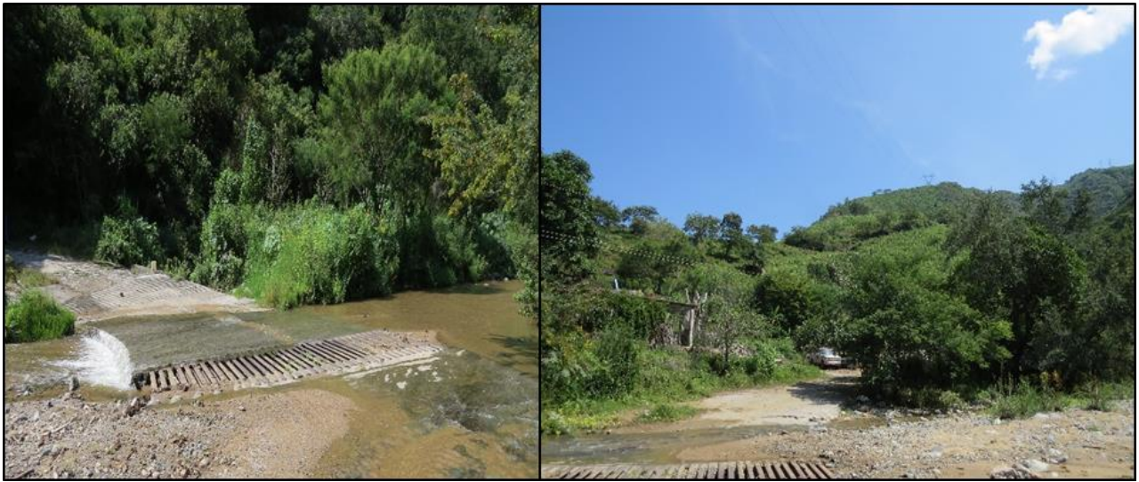
Figura 28. Vista de las condiciones actuales de la losa que se prevé modernizar
