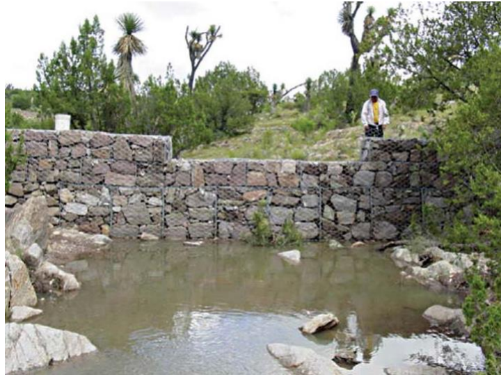
Figura 18. Presa de gaviones, imagen tomada de Vázquez et al. , (2007).
