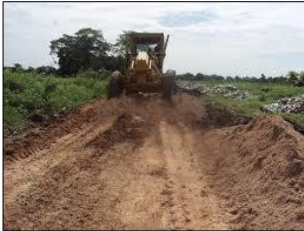
Figura 33. Ejemplificación del proceso de despalme
