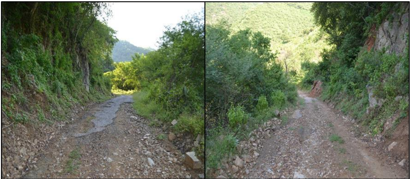
Figura 27. Vista de las condiciones del km 1+000 donde iniciarán las obras de mejoramiento y alineación del camino de acceso.
