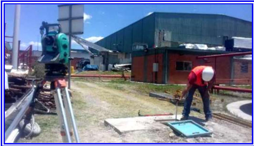
**IMAGEN II.2.6. REGISTRO DEL SISTEMA DE CONDUCCIÓN DE AGUA PLUVIAL**
