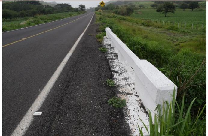
Descripción de la condición. – Se observa discontinuidad en asfalto compactado en el área situada entre el ancho de calzada y parapetos. Al finalizar el puente sólo se observa material pétreo asfaltado no compactado.
