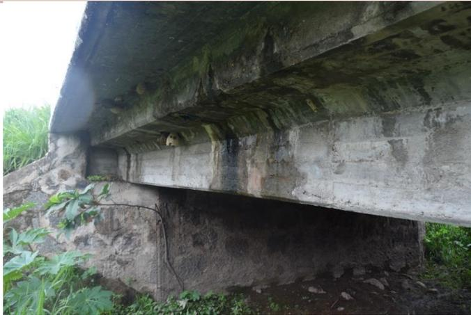
Descripción de la condición. – Se observa losa-viga del lado derecho del camino con manchas verdes y efloramiento por acumulación de humedad, así como algunos nidos de avispas.
