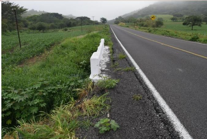
Descripción de la condición. – Se observan fisuras en los bordes del ancho de calzada del lado derecho del camino con vista hacia atrás (según el sentido del cadenamiento).
