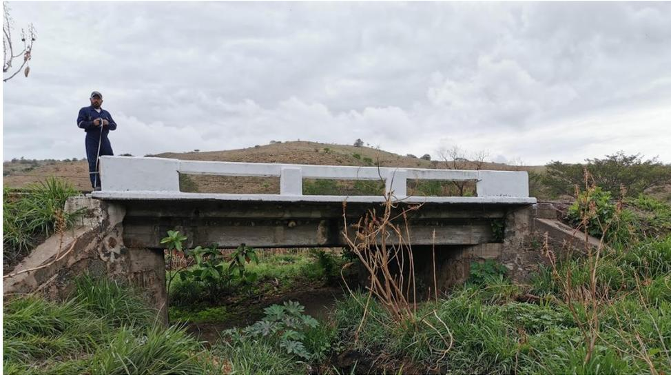
**Figura 4. Subestructura del Puente “El Zapote”**
