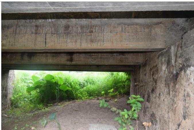
Descripción de la condición. – Se observan desconches en el sistema de piso, así como algunas manchas de humedad. También se observa azolve por acumulación de material pétreo en el claro del puente, sobre el estribo No.2
