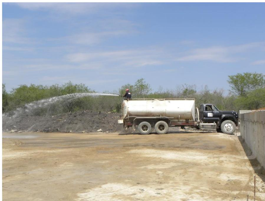
Figura 4. Riego de suelo mediante pipas
