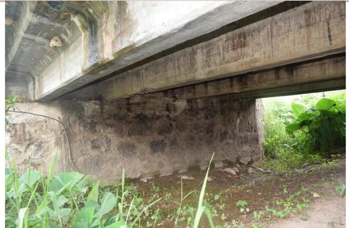
Descripción de la condición. – Se observa humedad y manchas en las losas-vigas que conforman la superestructura del puente. Se observa desconche de concreto con exposición de acero de refuerzo en segunda losa-viga y desconche menor en tercer losa-viga-
