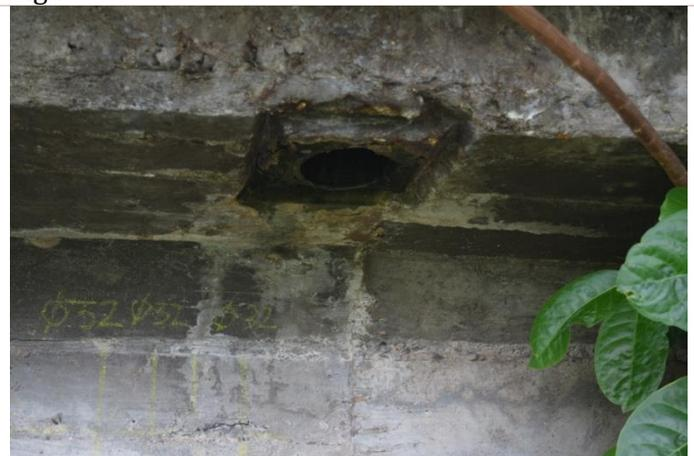
Descripción de la condición. – Se observa dren sin extensión, lo que conlleva a la acumulación de humedad y efloramiento sobre la losa-viga del puente, así como problemas de desconches de concreto.
