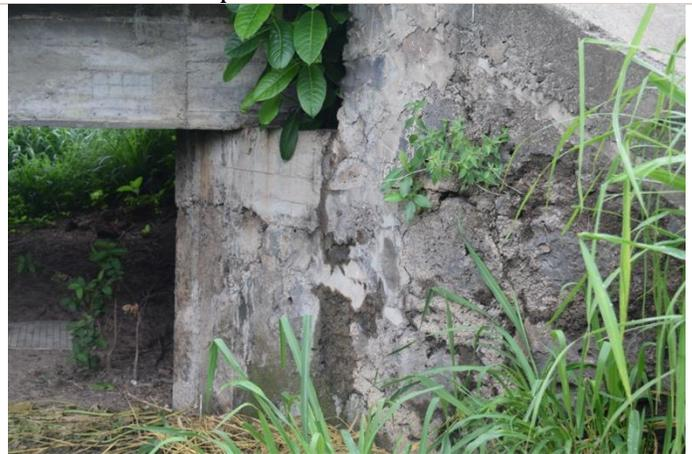
Descripción de la condición. – Se observa agrietamiento del concreto reforzado de apoyos, retención de humedad e invasión de vegetación el los mismos, así como algunos residuos sólidos.
