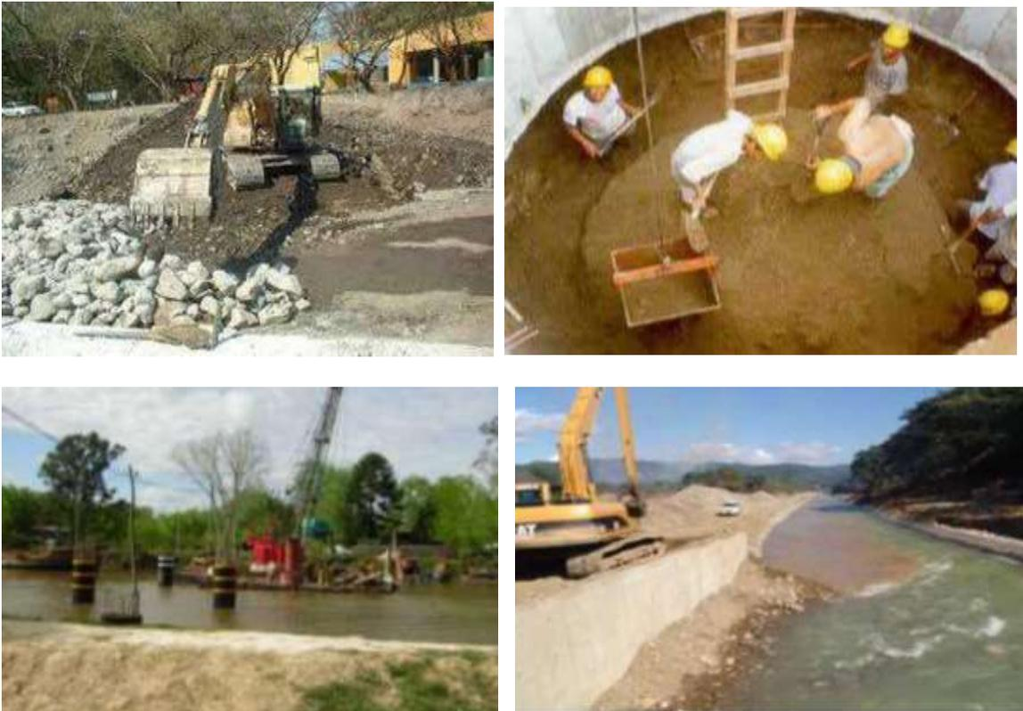
Figura II.18. Las imágenes muestran ejemplos típicos de la construcción de ataguías para facilitar el desplante de la cimentación de un puente sobre un río.
