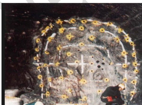
Imagen 20. Empleo de la voladura controlada en proyectos de ingeniería civil
