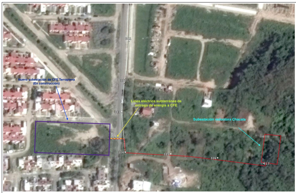
Imagen 11. Localización de la subestación
