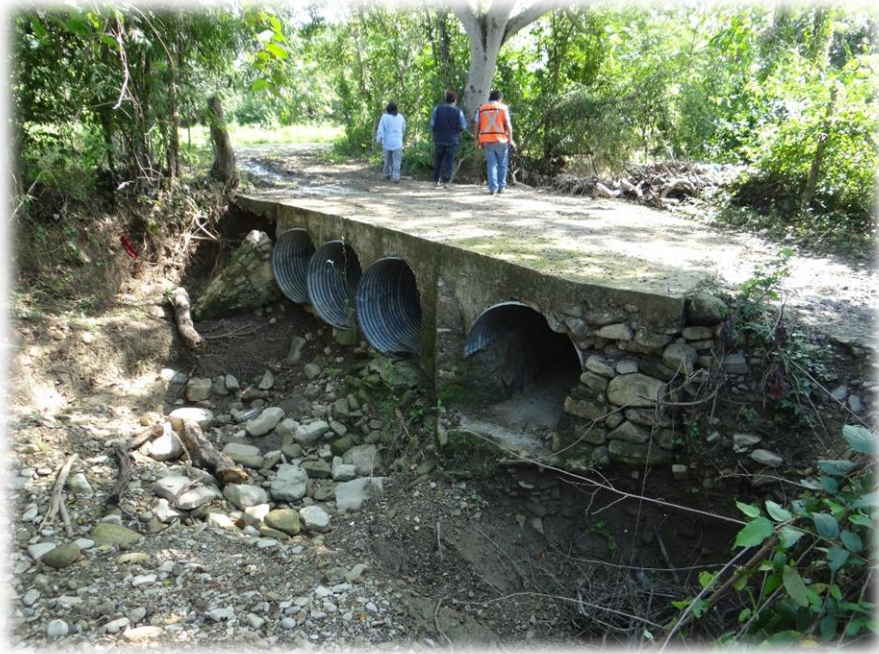
Figura V. 18. Obras de drenaje existentes usadas como paso de fauna.
