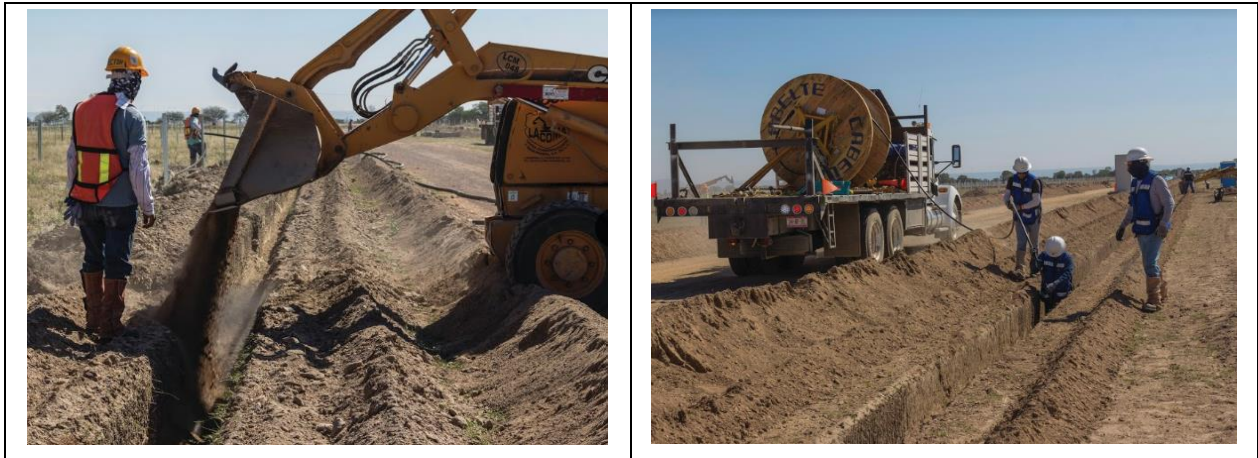
Figura II.28 Ejemplo de excavación de zanjas y tendido de cable
