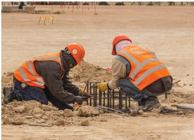
Figura II.31 Ejemplo de construcción de cimentaciones menores
