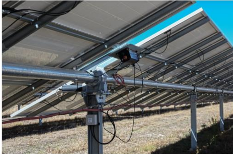
Figura II.7 Ejemplo del seguidor solar o tracker
