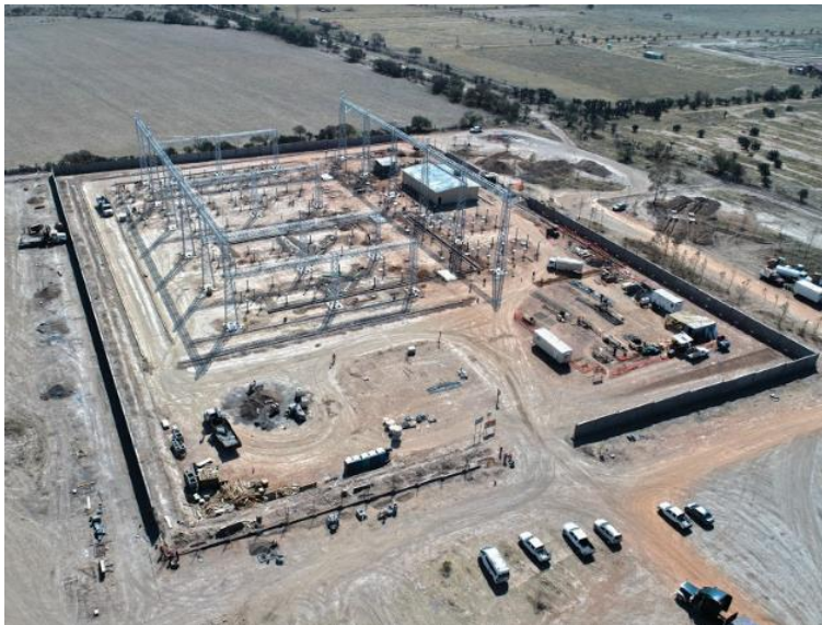
Figura II.29 Ejemplo de construcción de subestación de maniobras
