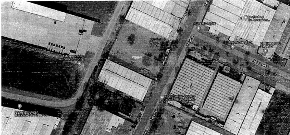
Imagen satelital de la ubicación de la nueva nave, en la Ciudad Industrial de León, Gto.
