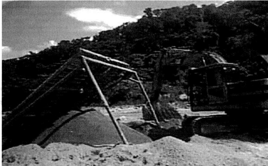
La piedra de diferentes calibres y gravillas resultante del cernido serán retiradas de inmediato del área de cribado al concluir la actividad de cernido, para ser depositadas en la franja de 3 metros de ancho medida de la base de pateo de los taludes hacia el centro del cauce, en el tramo donde se realiza la extracción o dragado, con el objeto de proteger y/o fortalecer los taludes.
