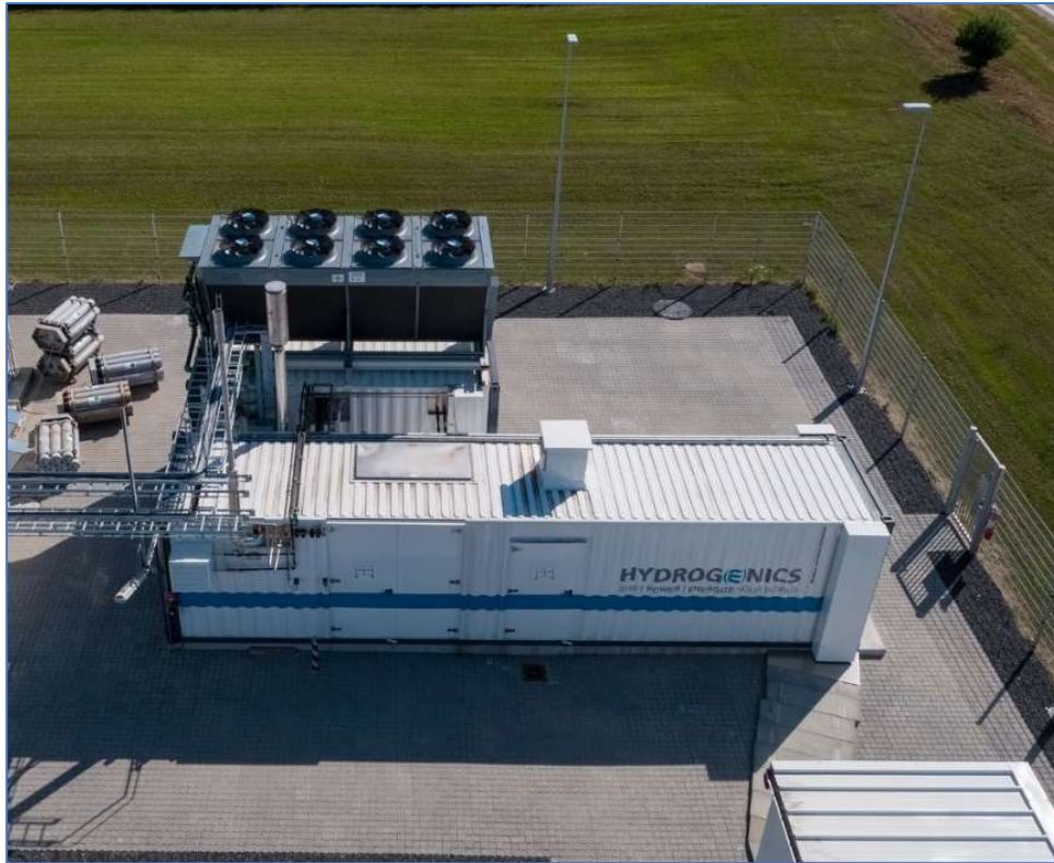
Figura II.28. electrolizador y sus auxiliares
