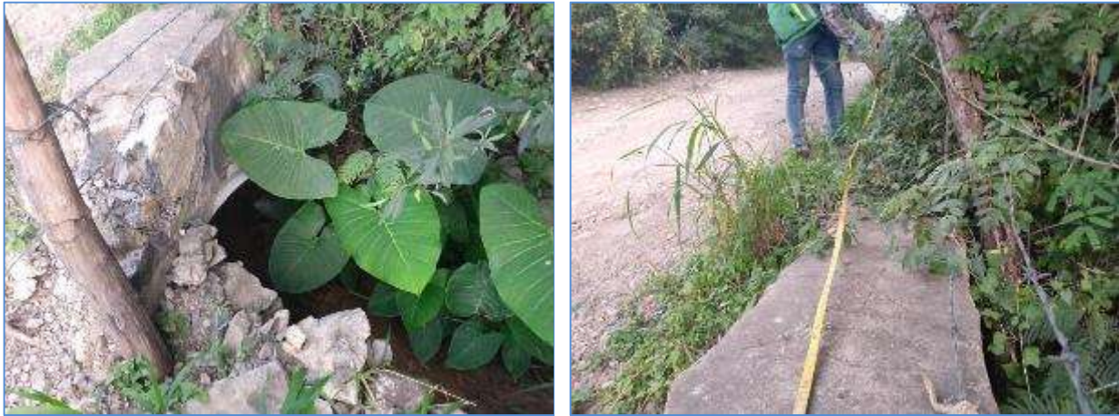
Figura II- 14. Fotografías del estado actual “Obra de drenaje 4”
