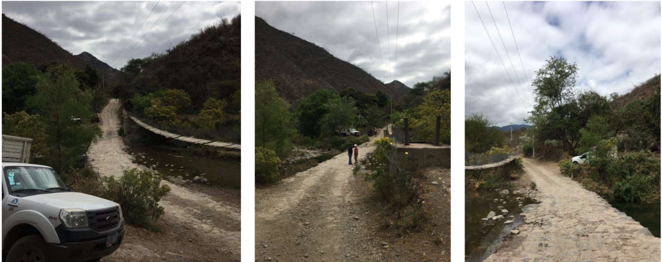
Figura IV-19. Condiciones actuales del Arroyo Catarina del Mezquital en su cruce con la zona de proyecto.
