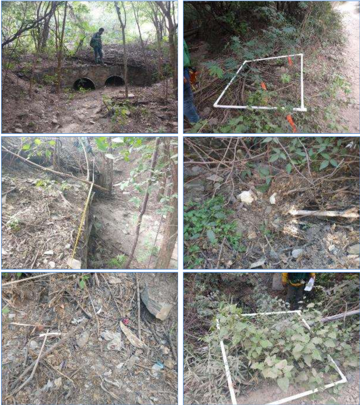
Figura II- 12. Fotografías del estado actual “Obra de drenaje 2”
