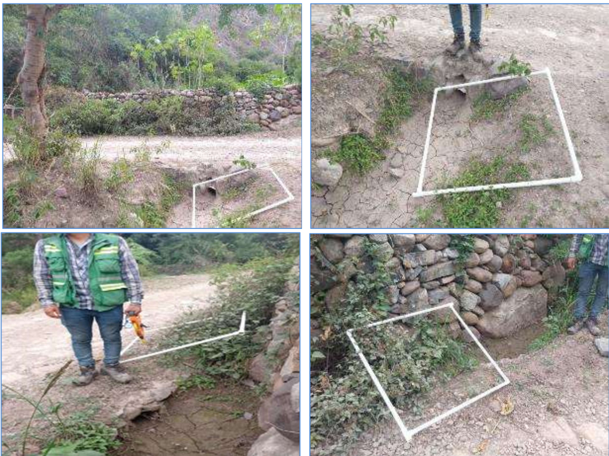
Figura II- 13. Fotografías del estado actual “Obra de drenaje 3”
