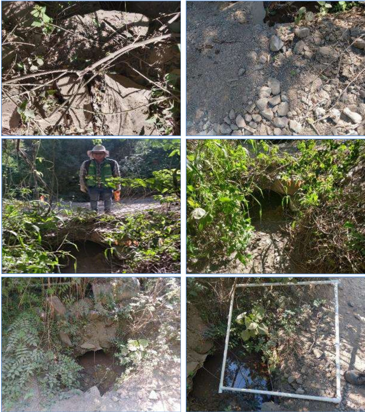
Figura II- 11. Fotografías del estado actual “Obra de drenaje 1”
