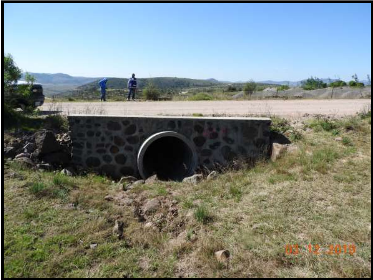
FIG.4.21 VISTA DE UNA OBRA DE DRENAJE EXISTENTE
