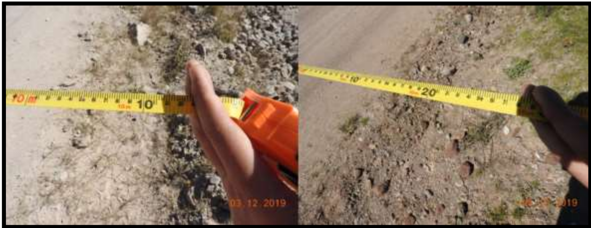
FIG.2.14 VISTA DE LA CARRETERA EXISTENTE DONDE SE APRECIA QUE CUENTA CON ESPACIO SUFICIENTE PARA LA MODERNIZACION
