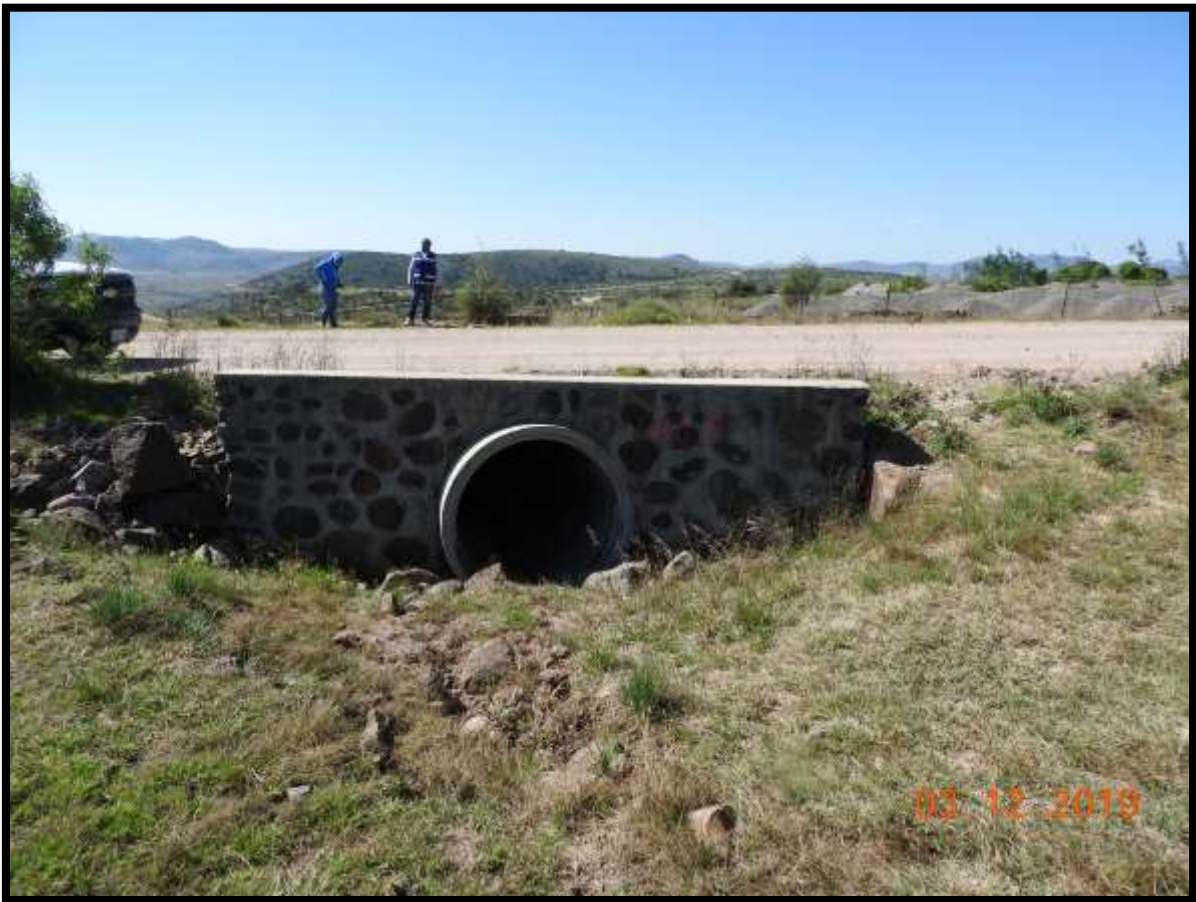
FIG.2.24 VISTA DE OBRA DE DRENAJE ACTUAL
