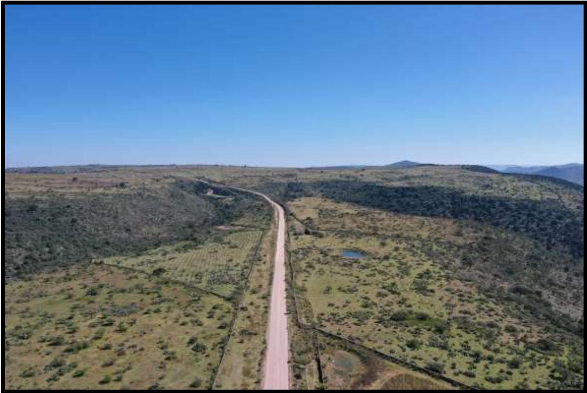
FIG.4.28 VISTA DEL CAMINO DE LA CARRETERA EXISTENTE Y DE LA VEGETACIÓN A LO LARGO DEL PROYECTO
