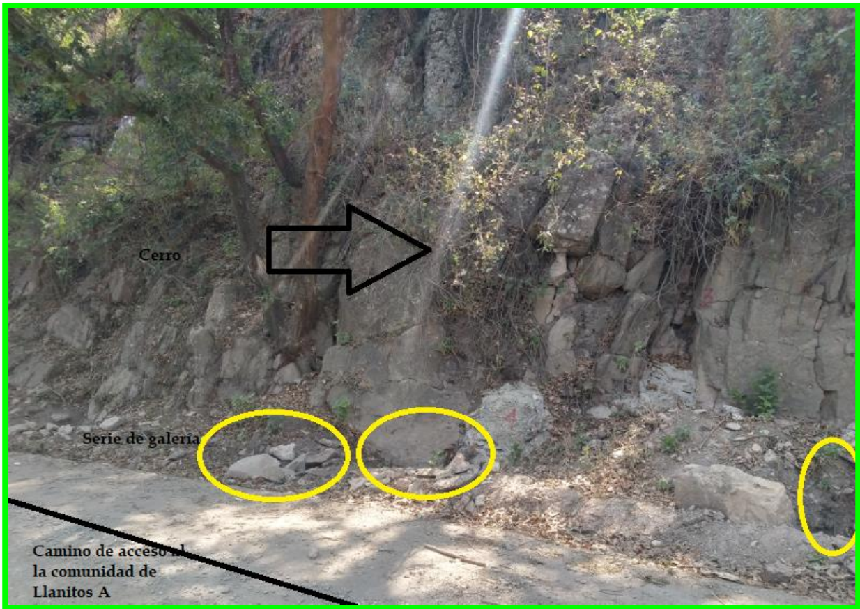
Ilustración 22. Sistema de captación del manantial sobre camino de acotamiento.
