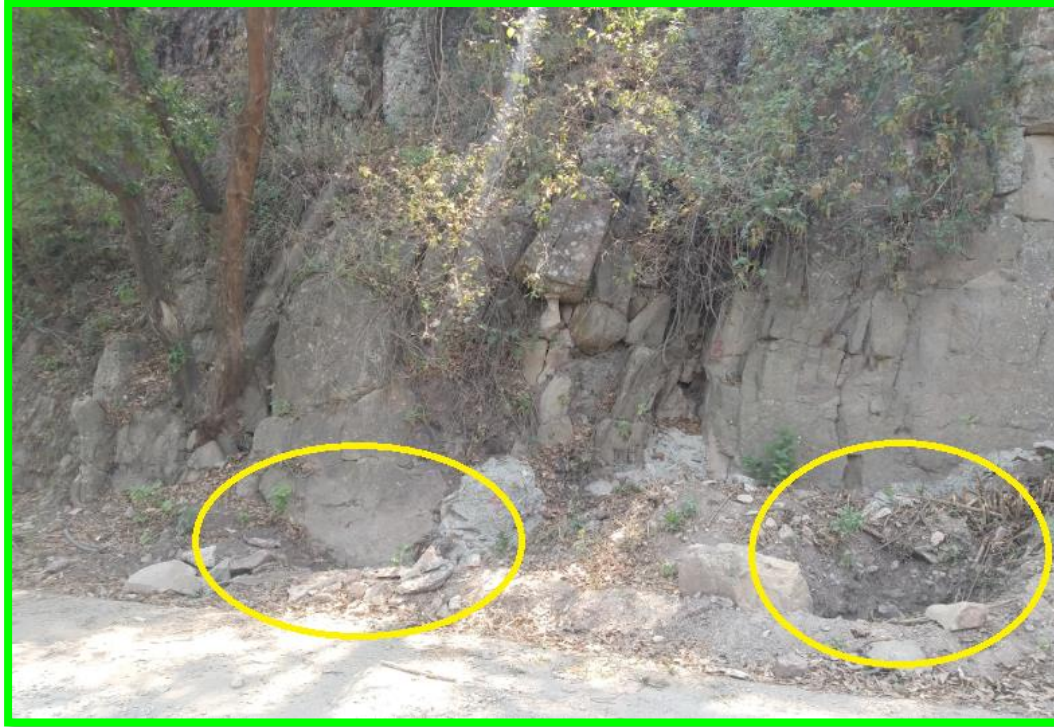
Ilustración 3. Se observa la manera de captación de las galerías filtrantes.
