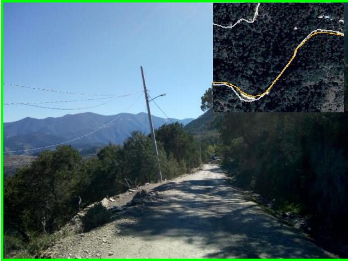
Ilustración 86. Camino de terracería después de la calle principal (pavimentada) sobre la que pasara la tubería de la línea de conducción superficial de agua potable.
