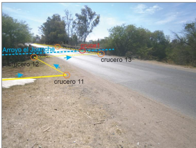
F15.- Vista hacia el trazo del proyecto en el cruce 1 con el Arroyo El Juanche; dentro de este trayecto se observan los cruces 11, 12 y 13, que pasarán por debajo del puente vehicular y se afectarán algunos pastos, gramma y maleza.
