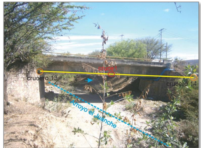
F17.- Vista hacia el trazo del proyecto en el cruce 1 con el Arroyo El Juanche; dentro de este trayecto se observan los cruces 13 y 14, que pasará adosado por debajo del puente vehicular y no se afectará vegetación.
