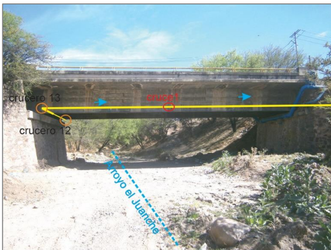
F18.- Vista hacia el trazo del proyecto en el cruce 1 con el Arroyo El Juanche; dentro de este trayecto se observan los cruces 12, 13 y 14, que pasará adosado por debajo del puente vehicular y no se afectará vegetación.
