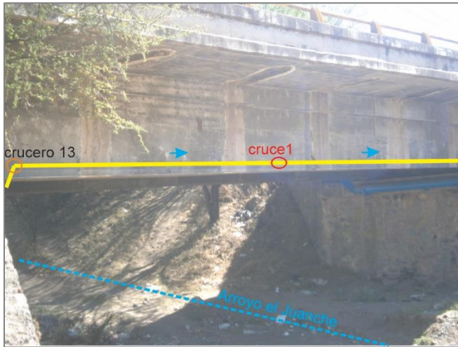
F19.- Vista hacia el trazo del proyecto en el cruce 1 con el Arroyo El Juanche; dentro de este trayecto se observan los cruceros 13 y 14, que pasará adosado por debajo del puente vehicular y no se afectará vegetación.
