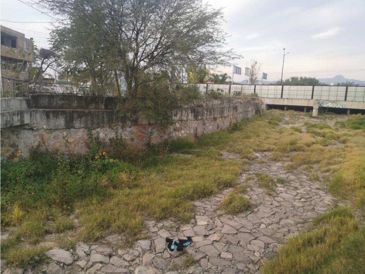
Mezquite dentro de la zona federal del canal
