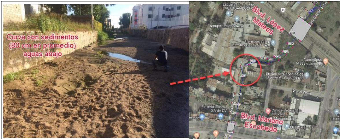
Curva en arroyo las liebres, principal zona llena de sedimentos.
