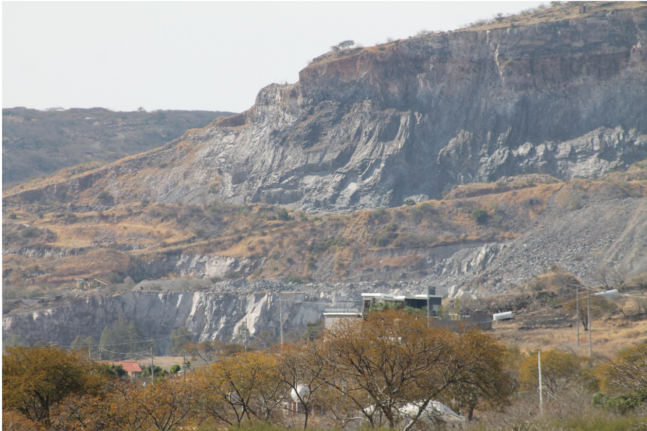
Imagen 29. Otro de los impactos negativos que se presentan en el SA es la explotación de material, lo que ha provocado la pérdida de vegetación, afectación del paisaje, pérdida de la topografía y de los servicios ambientales, ya que esta actividad que provoca severos daños.
