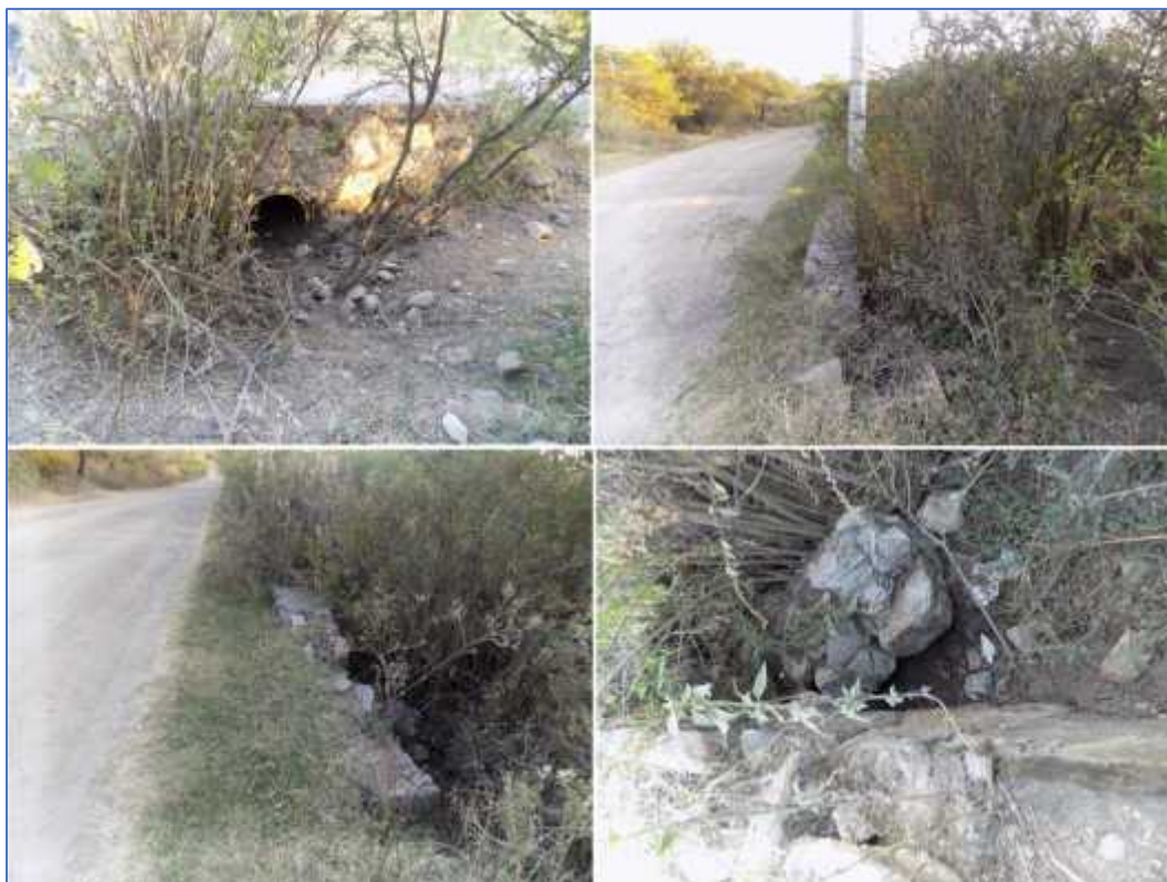
Figura 48. Condiciones generales que presenta la escorrentía intermitente "7", situada en el cadenamamiento 3+023.22.
