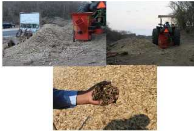
Figura 4. Ejemplo de la trituración y Composteo de material resultado del desmonte y despálme
