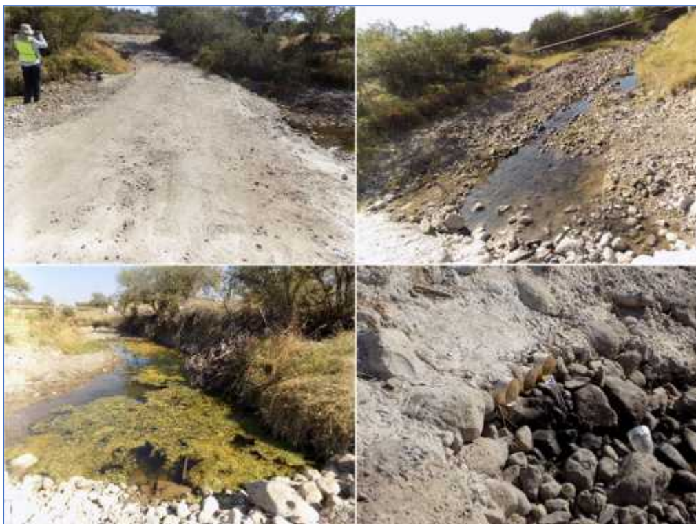
Figura 60. Condiciones generales que presenta la escorrentía intermitente "10", situada en el cadenamiento 7+312.29.
