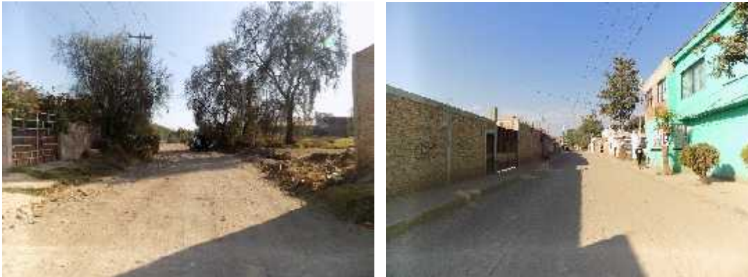
Figura 5. Inicio del proyecto km 0+000 al sur de la localidad de Puentecillas. (De izquierda a derecha), vista hacia enfrente y vista hacia atrás.
