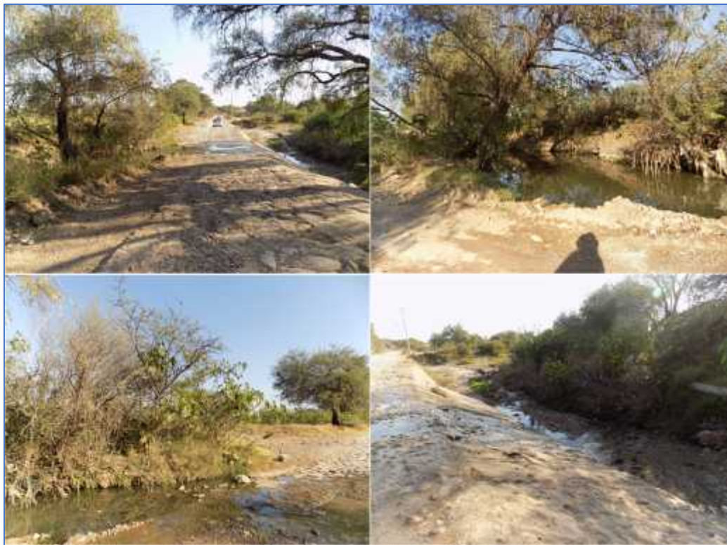
Figura 25. Condiciones generales que presenta el arroyo Yerbabuena situado en el cadenamiento 0+219.16.
