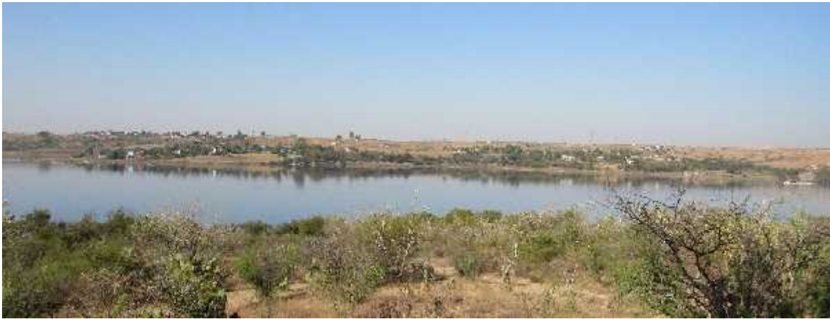
Figura 93. Panorámica de La Presa La Purísima.
