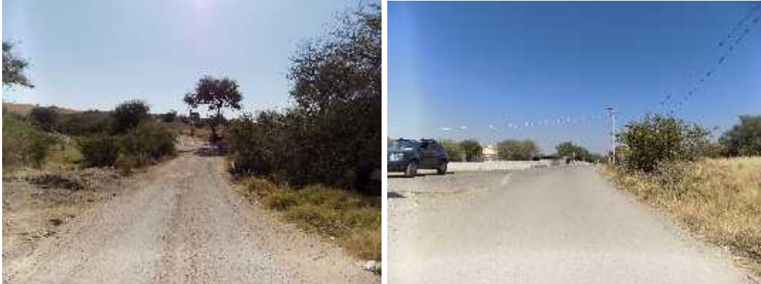
Figura 8. Inicio del segundo tramo (imagen de izquierda a derecha) vista hacia delante y vista hacia atrás.
