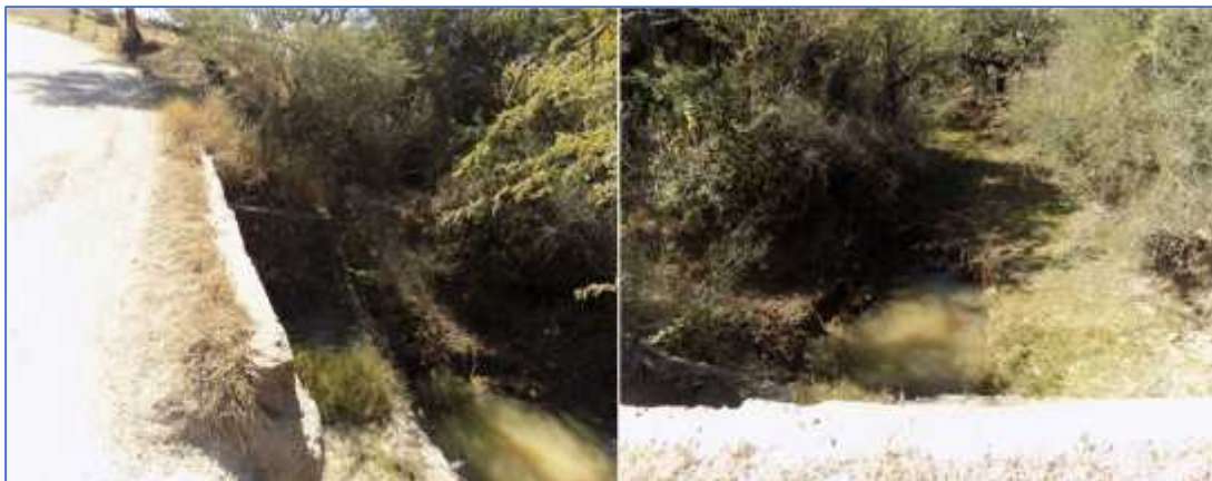
Figura 71. Condiciones generales que presenta la escorrentía intermitente "1", situada en el cadenamiento 0+026.63.
