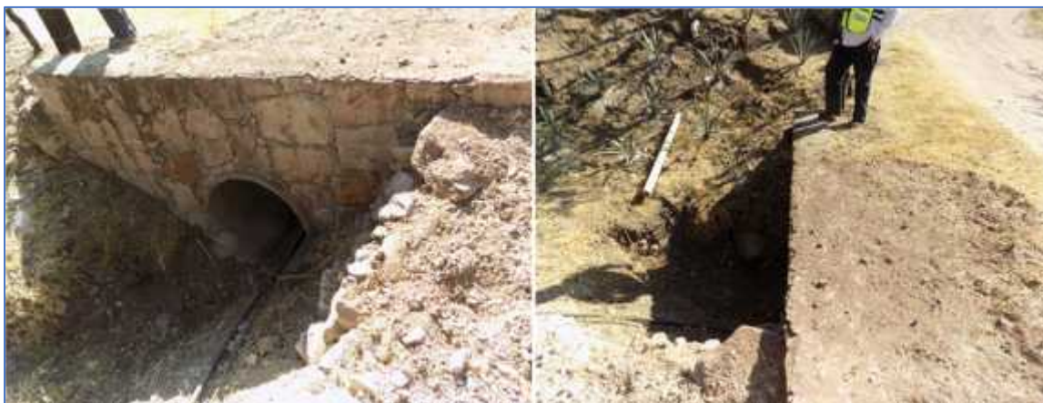
Figura 52. Condiciones generales que presenta la escorrentía intermitente "8", situada en el cadenamamiento 6+131.68.
