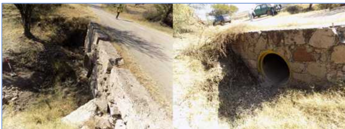
Figura 56. Condiciones generales que presenta la escorrentía intermitente "9", situada en el cadenamamiento 6+806.66.
