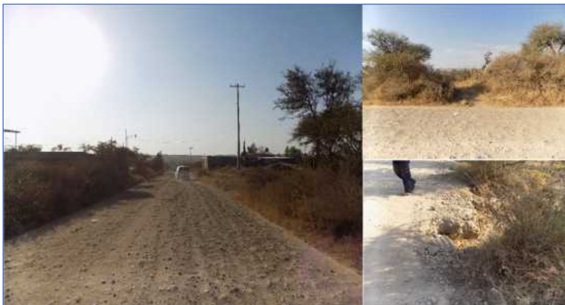
Figura 33. Condiciones generales que presenta la escorrentía intermitente "3", situada en el cadenamiento 0+996.60.
