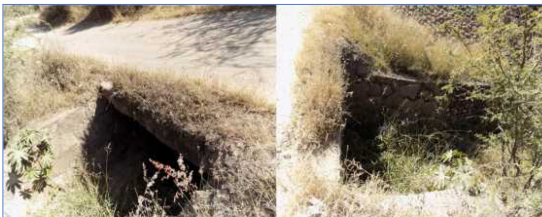
Figura 67. Condiciones generales que presenta la escorrentía intermitente "12", situada en el cadenamamiento 8+210.90.
