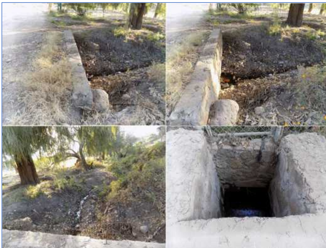
Figura 37. Condiciones generales que presenta la escorrentía intermitente "4", situada en el cadenamamiento 1+448.77.
