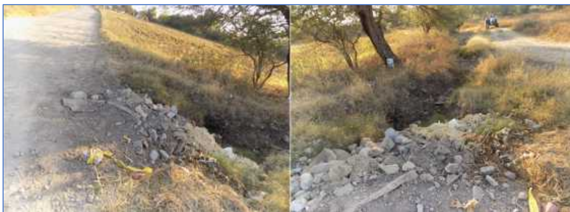
Figura 41. Condiciones generales que presenta la escorrentía intermitente "5", situada en el cadenamamiento 2+139.27.
