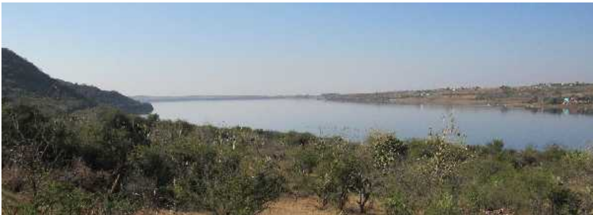
Figura 94. Panorámica de La Presa La Purísima.
