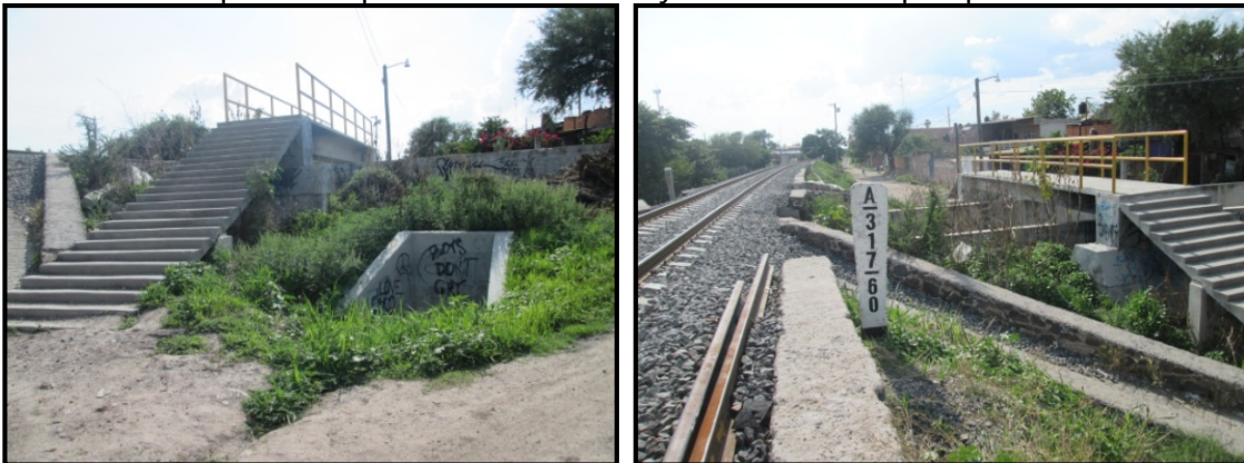
Fotos IV. 16 y 17. Arroyo Neutla (Canal revestido) en su paso bajo las vías férreas, en el sitio del proyecto ampliación del puente entre la vía actual y el área contraria al paso peatonal
