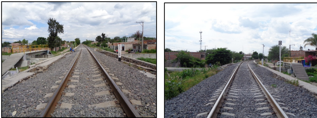
Fotos II.14 y II.15 Vista del puente a nivel de vía, izquierda vista hacia Celaya, derecha vista hacia Salamanca
