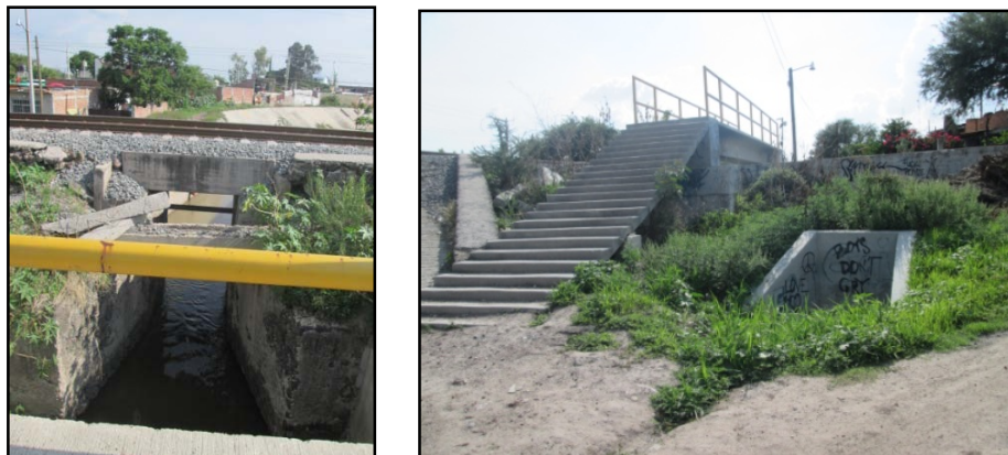
Fotos II.4 y II. 5 Vista del cauce del arroyo Neutla bajo el puente ferroviario y del paso peatonal aledaño ubicado al norte del puente
