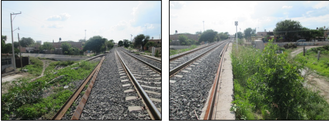
Foto II.10 y II.11. Puente sobre el arroyo Neutla dos vistas en dirección a Salamanca, en el sitio del proyecto de ampliación del puente
