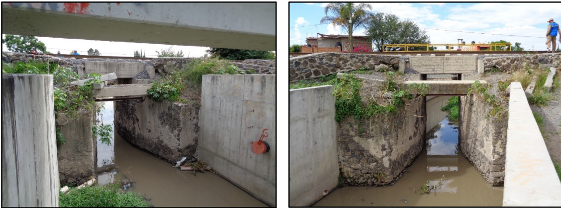
Foto II.12 Cruce del puente con el canal, vista lateral hombro derecho aguas arriba. Foto II.13 Cruce del puente con el canal, vista lateral hombro izquierdo aguas abajo
