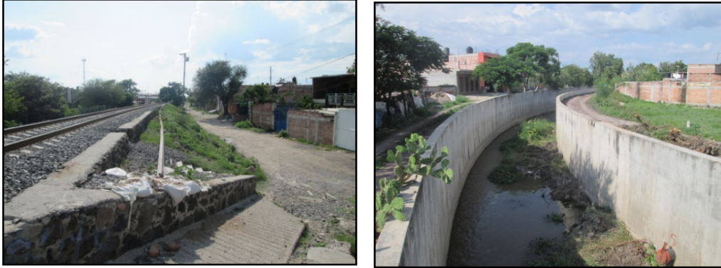
Fotos II.1 y II.2. Aspectos de la rampa noroeste y del canal revestido aguas abajo del puente
