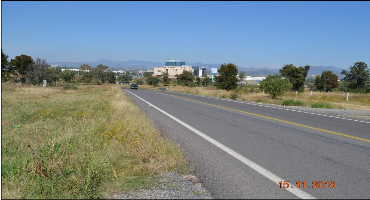
Figura 58. Condiciones del tramo 1 con pastizal inducido en la periferia del camino.
