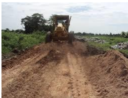
Figura 35. Ejemplificación del despalme
