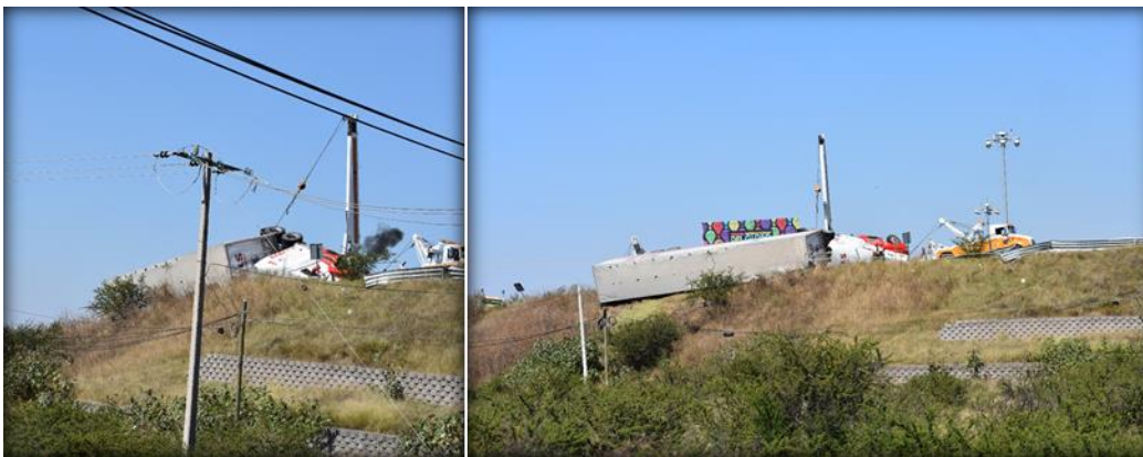
Figura 116. Accidente suscitado durante el levantamiento de campo.
