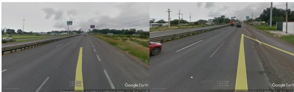
Figura 22. A. Condiciones carretera No. 45 sentido León Silao, a la altura del km 16+260. B. condiciones carretera No. 45 a la altura del km 16+460 sentido a León-Silao. En ambas imágenes se aprecia que el tramo a trabajar ya cuenta con los carriles de incorporación y desincorporación, por lo cual los trabajos de ampliación son escasos.
