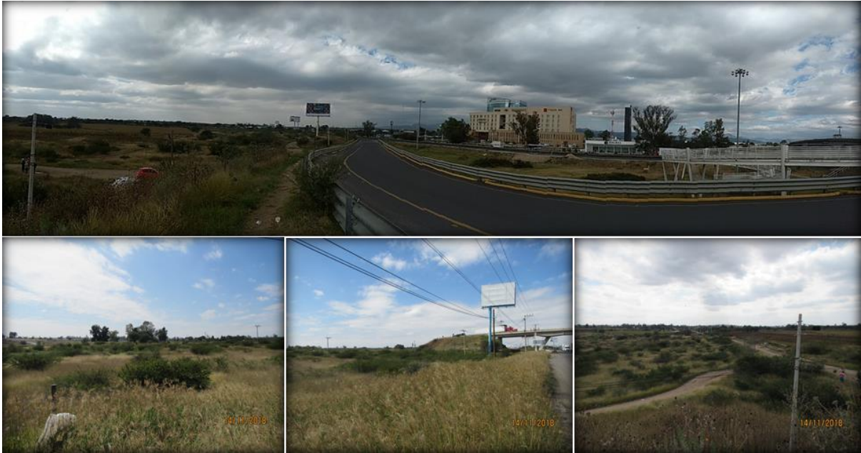
Figura 114. Vista general de la zona donde se localizará el proyecto.
