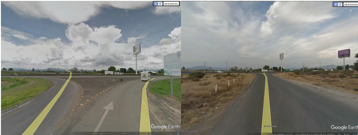
Figura 27. Ubicación del sitio de acceso con boyas existentes (imagen izquierda) y del sitio donde se ubicará la glorieta (foto derecha)
