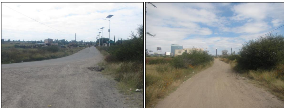
Figura 16. Condiciones actuales del camino Loza de Barrera en el tramo de aprovechamiento
