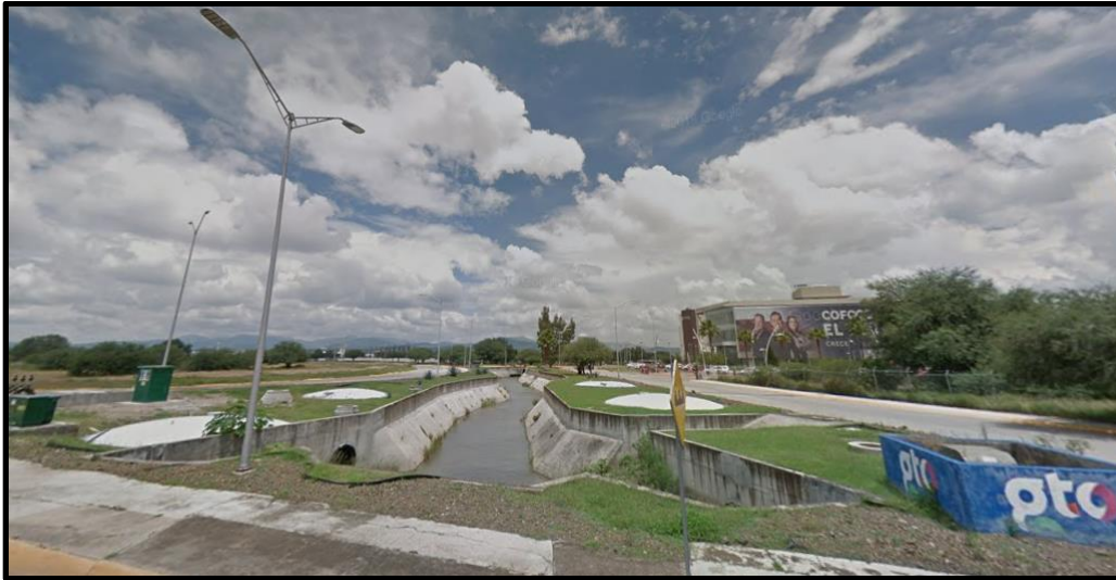
Figura 32. Río arriba de la carretera federal León-Silao, zona del puerto interior, estructuras de canalización de la corriente.
