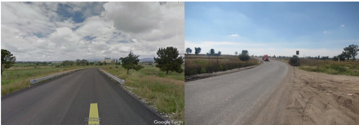
Figura 7. Condiciones actuales del camino A Romita en el tramo de aprovechamiento
