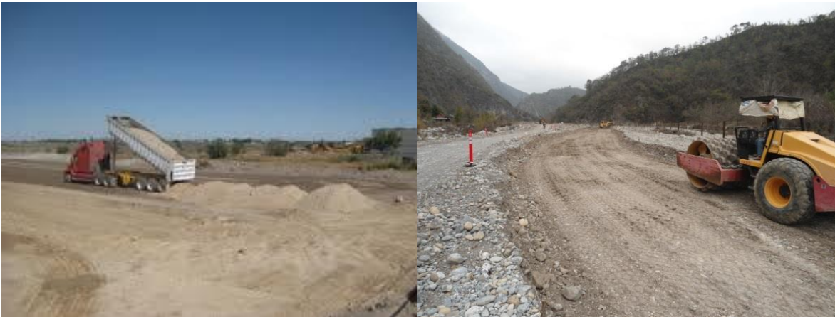
Figura 44. Ejemplificación de conformación de base hidráulica
