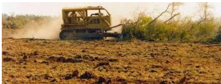
Figura 34. Ejemplificación del proceso de desmonte
