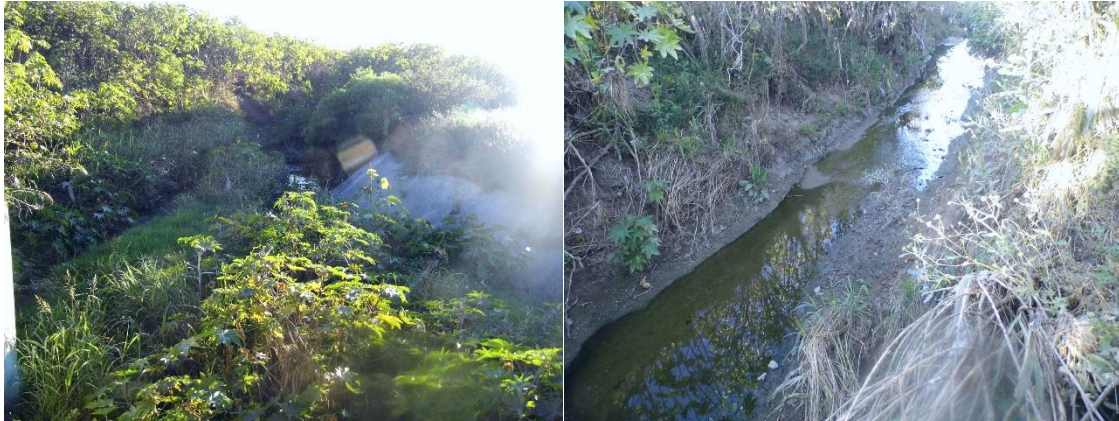
Figura 36. Desemboque de drenaje y paso de la corriente RH12Bd, ID: 4566796.
