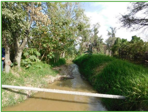
Imagen. Vista actual del cauce del arroyo Tres Marías, mismo que se encuentra azolvado.
