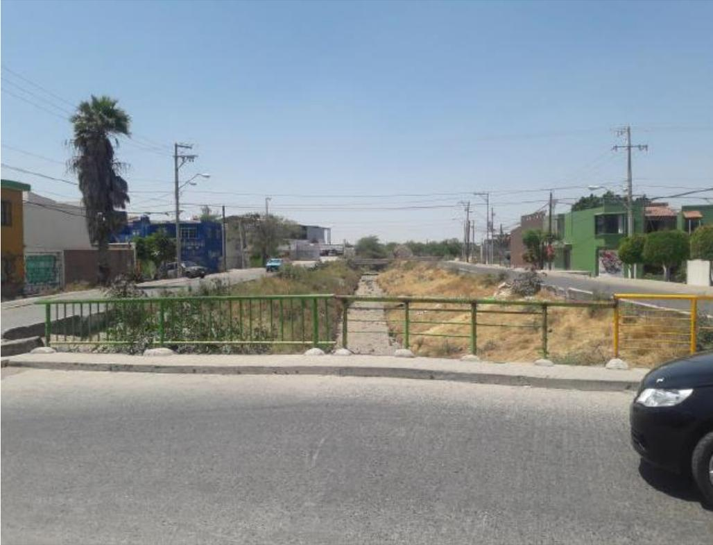
Arroyo de Las Liebres visto hacia aguas abajo desde el puente vehicular de la calle Fray Alonso de Montufar. Se aprecia la sección trapecial en tierra.
