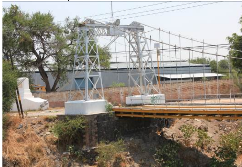
FOTOGRAFÍA 26. Cimentación de mampostería existente.
