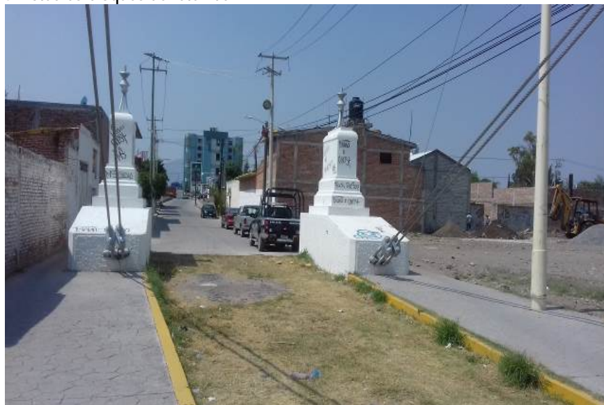
FOTOGRAFÍA 4. Actuales bloques de retenida.
