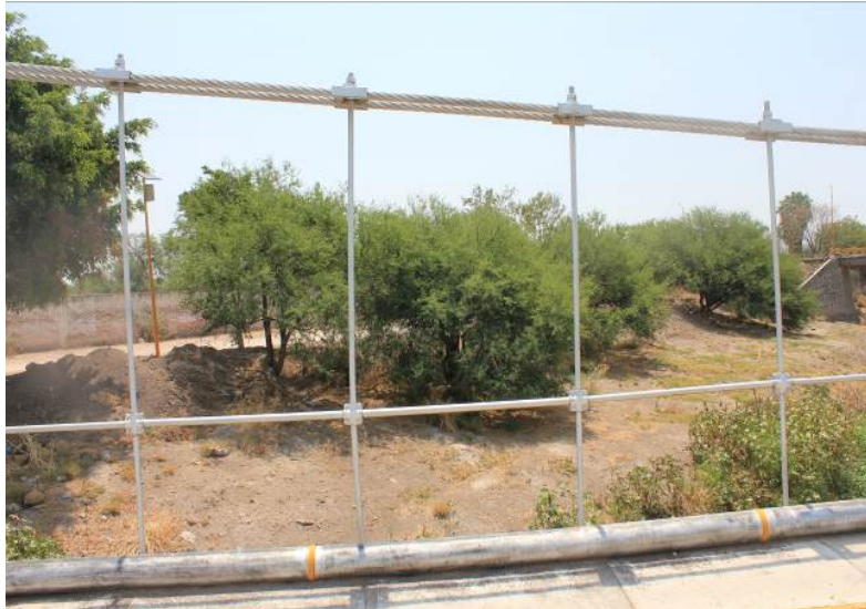
FOTOGRAFÍA 32. Péndolas de la actual estructura.
