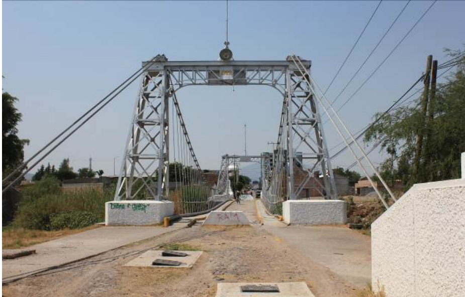
FOTOGRAFÍA 19. Actual pórtico integrado por una armadura de acero estructural.
