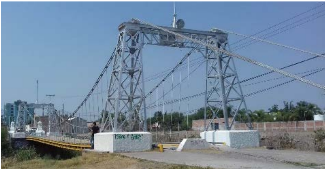
FOTOGRAFÍA 11. Condiciones actuales del Puente Peonatal.
