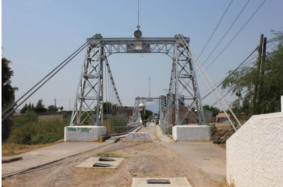
FOTOGRAFÍA 3. Actual pórtico integrado por una armadura de acero estructural.
