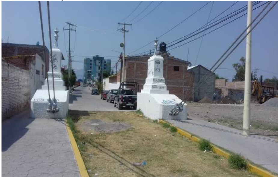
FOTOGRAFÍA 20. Actuales bloques de retenida.
