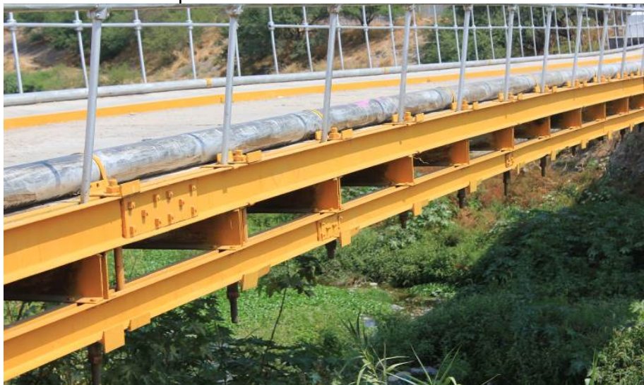
FOTOGRAFÍA 22. Actual sistema de piso.
