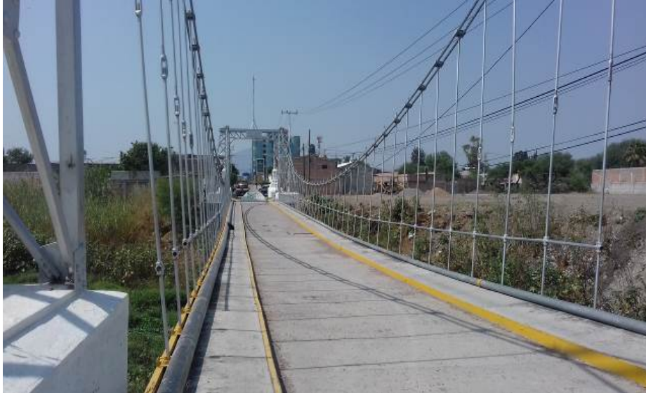
FOTOGRAFÍA 21. Péndolas de la actual estructura.
