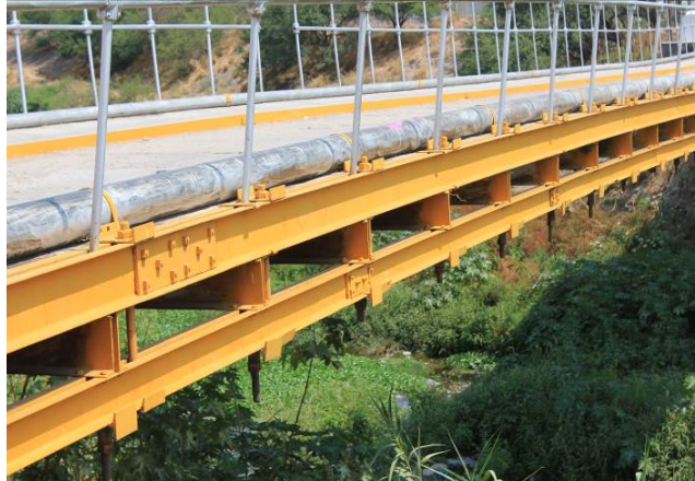
FOTOGRAFÍA 6. Actual sistema de piso.
