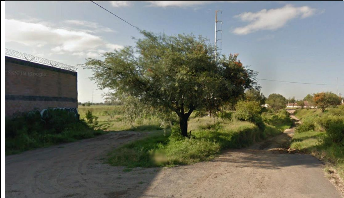
Vista del trazo del arroyo Tajo de Santa Ana de norte a sur, a la izquierda se observa la subestación de CFE.
