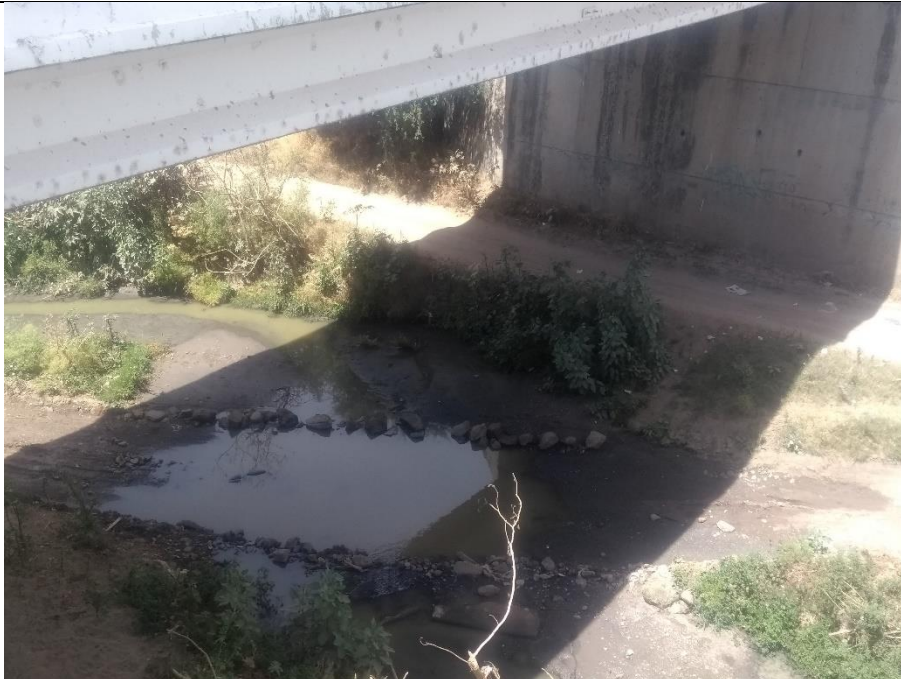
Vista desde el puente de la autopista Salamanca-León hacia el arroyo Tajo de Santa Ana, donde se llevara a cabo el cruce de tubería por el método de hincado.
