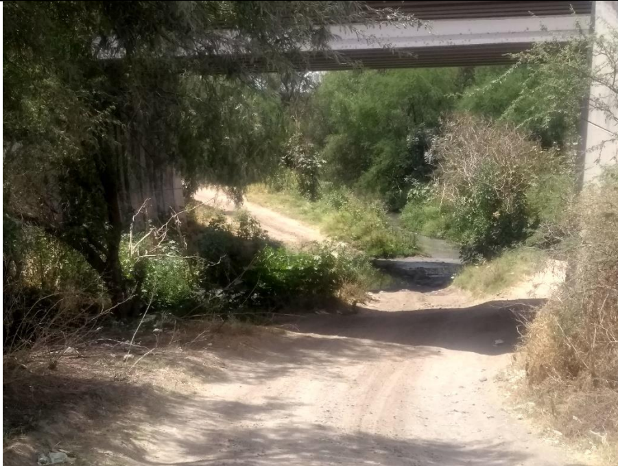
Vista de norte a sur del puente de la autopista León-Aguascalientes el arroyo Tajo de Santa Ana, donde se llevara a cabo el cruce por el método de hincado.
