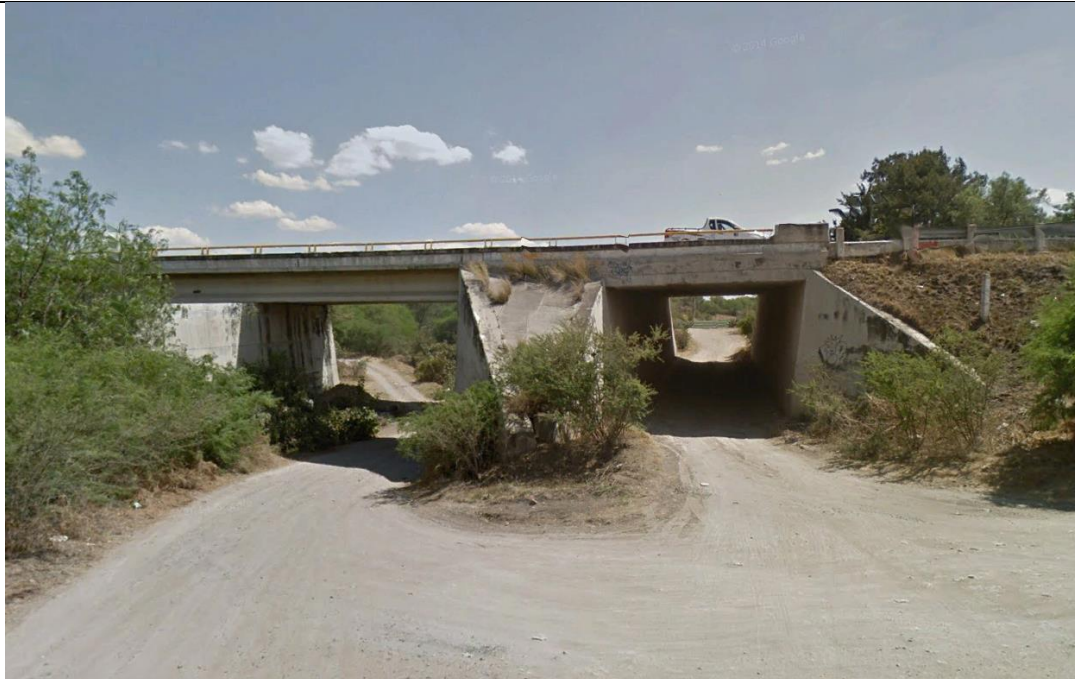
Vista de norte a sur del puente de la autopista León-Aguascalientes el arroyo Tajo de Santa Ana. Se observan dos cuerpos uno para cruce vial y otro sobre el arroyo.
