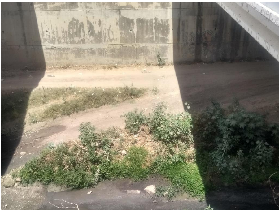
Otra vista desde el puente de la autopista Salamanca-León hacia el arroyo Tajo de Santa Ana, donde se llevara a cabo el cruce de tubería por el método de hincado.
