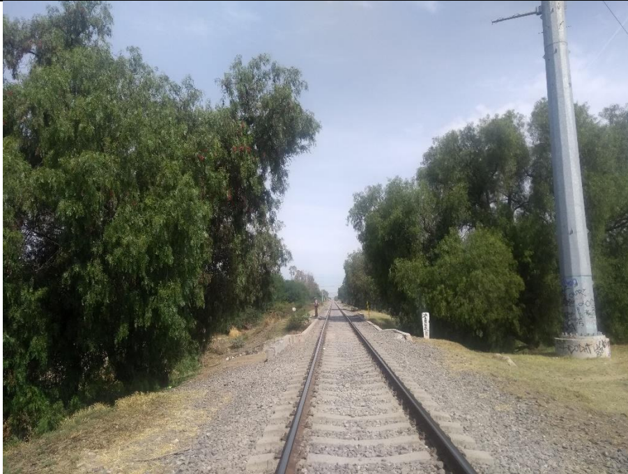
Vista de las vías del ferrocarril en el lugar donde se llevara a cabo el cruce por el método de hincado.
