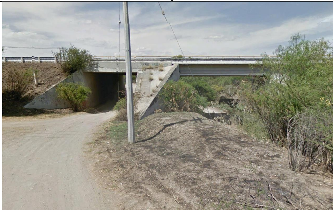
Vista de sur a norte del puente de la autopista León-Aguascalientes el arroyo Tajo de Santa Ana. Se observan dos cuerpos uno para cruce vial y otro sobre el arroyo.
