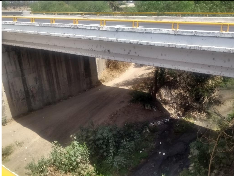
Vista de norte a sur del puente de la autopista Salamanca-León sobre el arroyo Tajo de Santa Ana.
