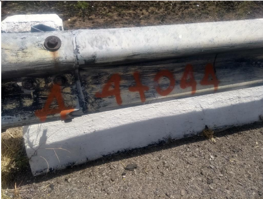
Vista del cadenamiento de las vías del ferrocarril en el lugar donde se llevara a cabo el cruce por el método de hincado.
